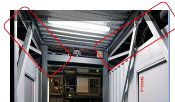
Figure 32: croisement des poteaux métalliques 46
