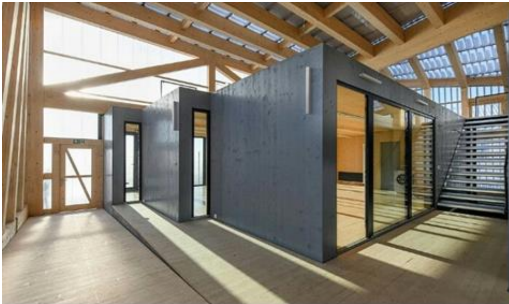
Figure 10: bâtiment modulaire en bois 11
