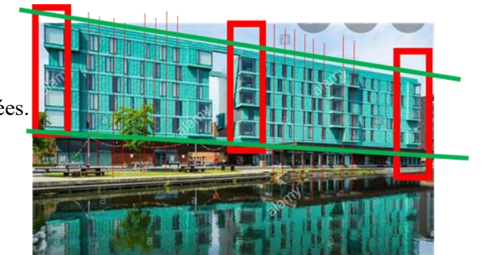
Figure 27: façade de la cité universitaire 42
