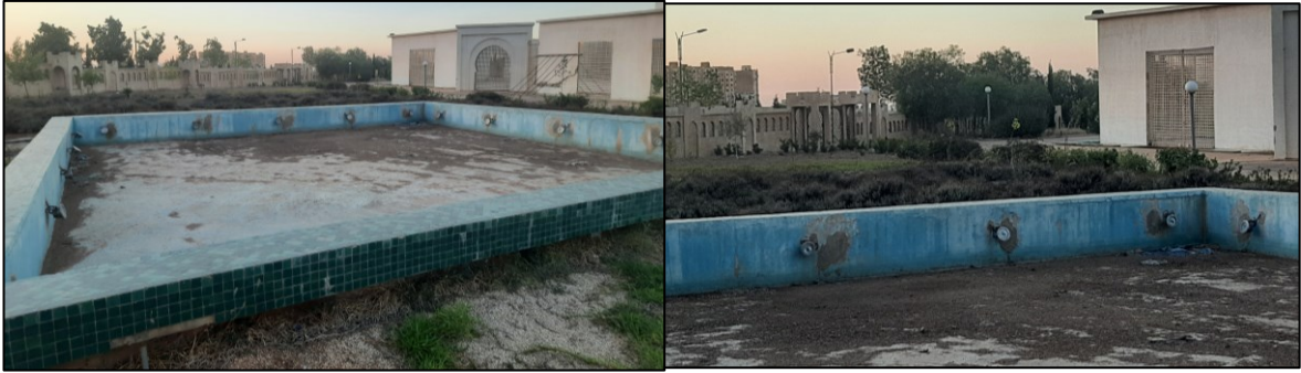
Figure 29 : le bassin. Source : l'auteur
