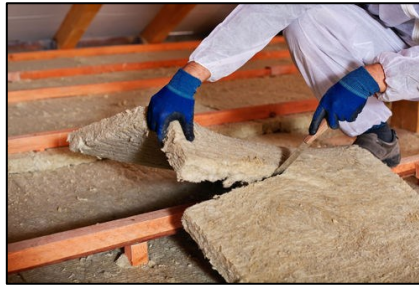
Figure 83 : Utilisation de la laine de roche.
