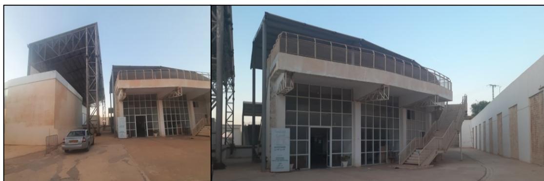
Figure 28 : foyer vu d'extérieur. Source : l'auteur
