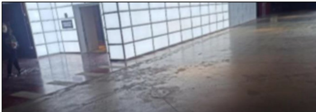
Figure 53 : accès au centre commercial à partir du parking.
