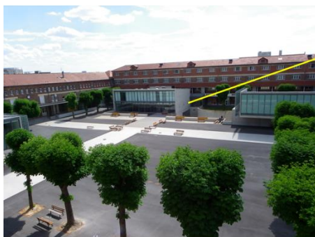
la médiathèque (CDI) surmontée de salles informatiques
