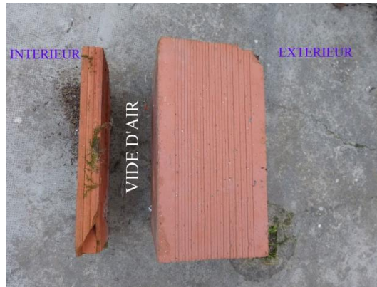
Figure 79. configuration de murs à double paroi 46
