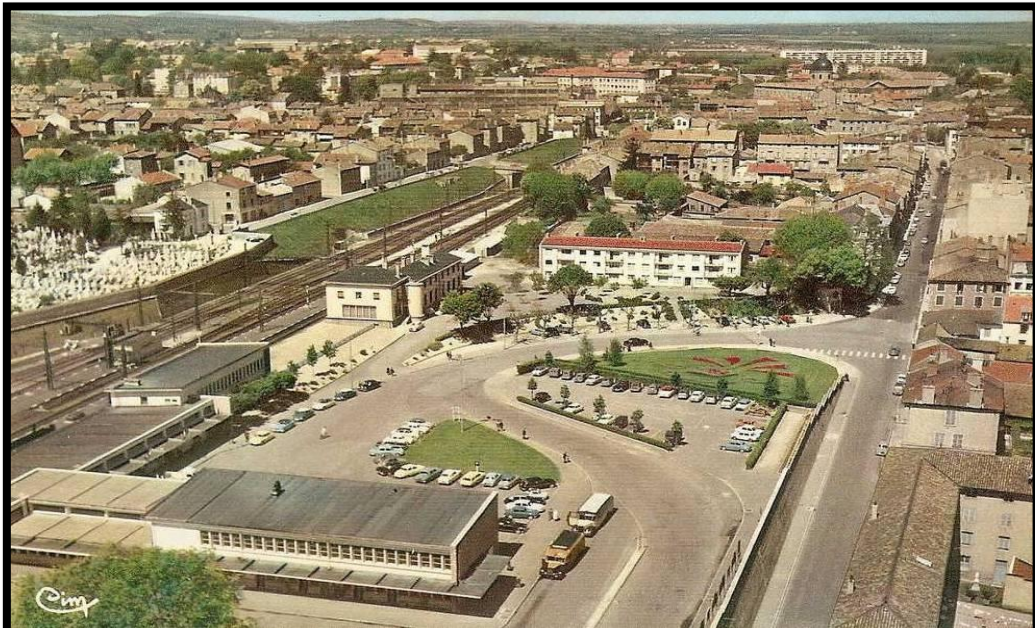
صورة 62: منظر جوي للمحطة مصدر: google image
