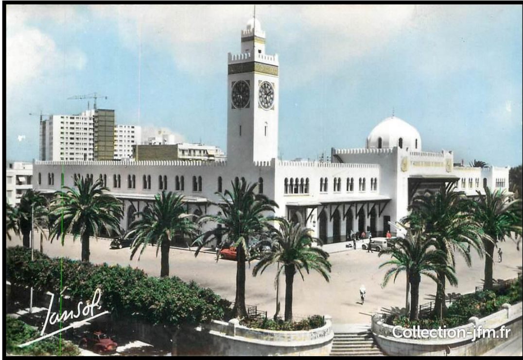
صورة 76: صورة المحطة
