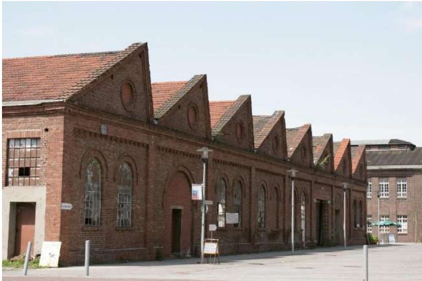
Figure 120 Toiture à sheds à Herten (Allemagne).
