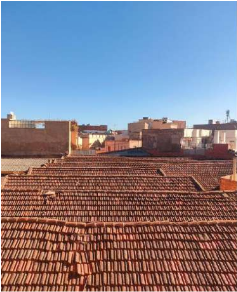
Figure 62 Photo prise en octobre 2022 montrant la toiture Source : Auteur
