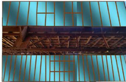
Figure 105 Essai du remplacement du verre de la toiture (Avant /Après)
