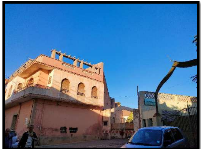
Figure 42 Photo de l'entrée de l'usine Ghomri
