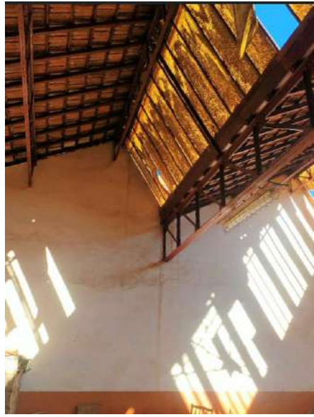
Figure 61 Photo prise en octobre 2022 montrant la toiture Source ; Auteur
