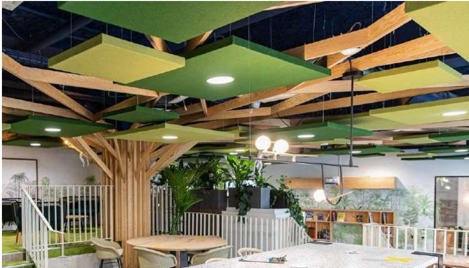
Figure 119 Exemple des panneaux acoustiques
