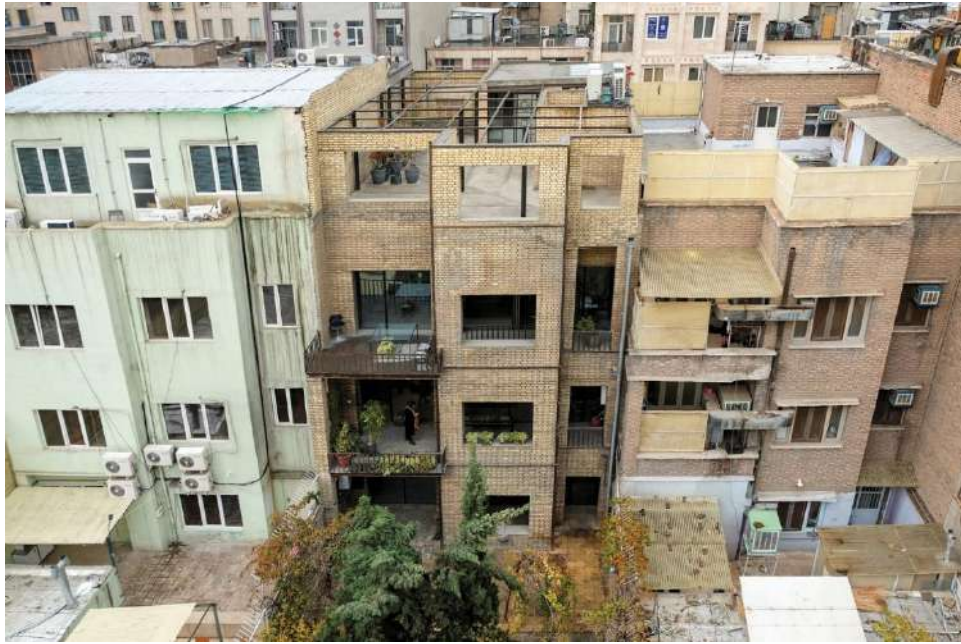
Figure 73 Photo réelle du projet
