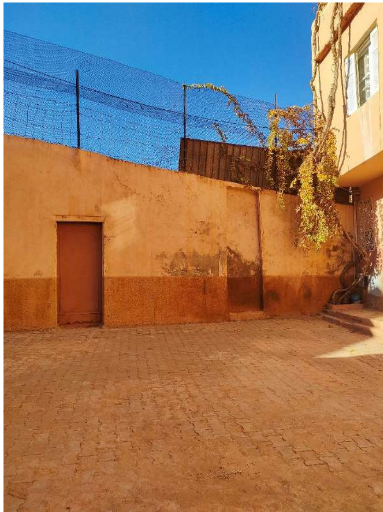
Figure 59 Photo prise en octobre 2022 démontrant l'entrée de secours Source : Auteur
