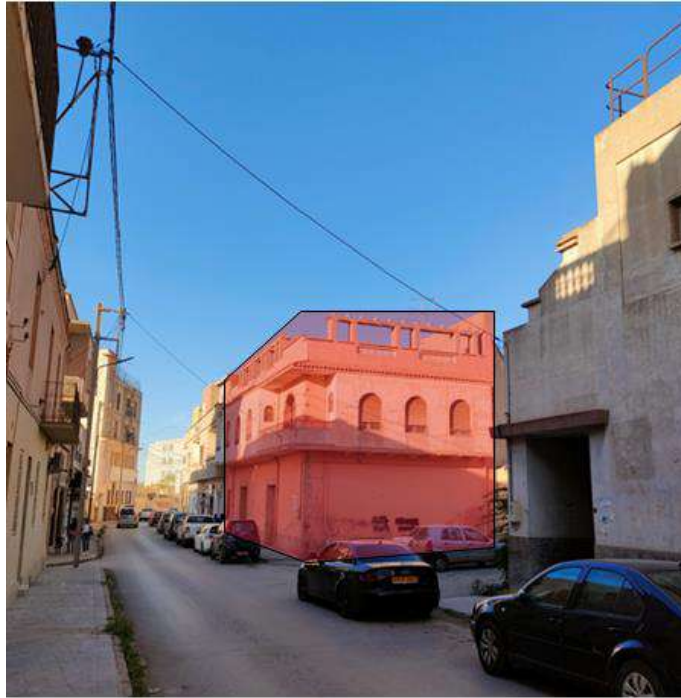
Figure 57 Photo prise en octobre 2022, démontrant l'habitation en face de l'usine de tapis près du cinéma Lux
