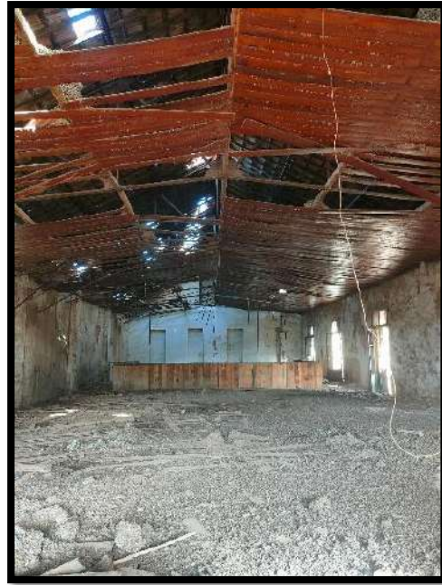
Figure 40 Photo de l'intérieur de l'Usine Gaouar
