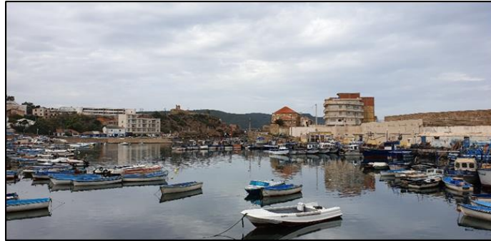
Figure 26 : Vue sur la zone d'étude Source : Auteur.
