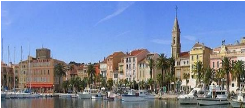
Figure 37: Corniche de sanary sur mer Source : Site web « sanary-tourisme.com »
