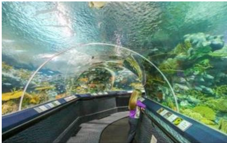
Figure 62: Tunnel sous-marin Source : Site web « www.leszoosdanslemonde.fr »
