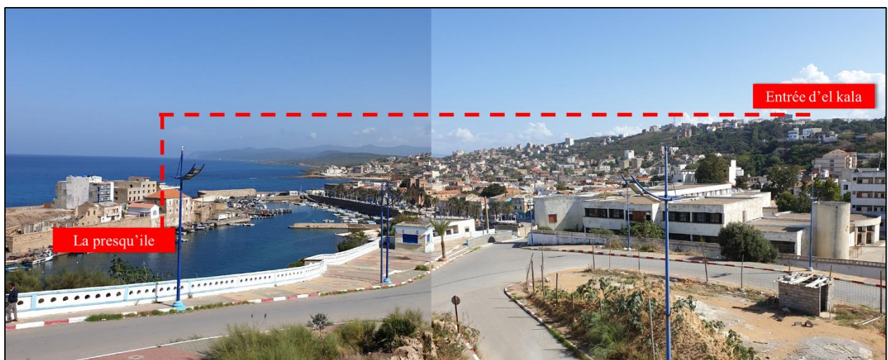
Figure 71 : Photo qui montre la différence de niveau entre la ville et la presqu'île. Source : Auteur.
