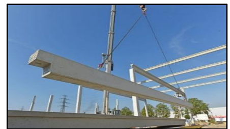
Figure 11 : Poutres préfabriquées en béton
