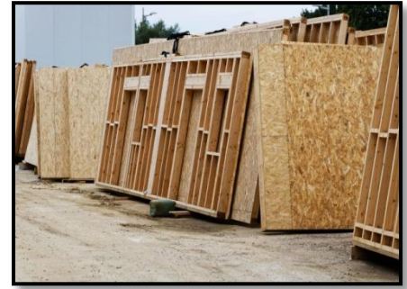
Figure 19 : le bois préfabriqué
