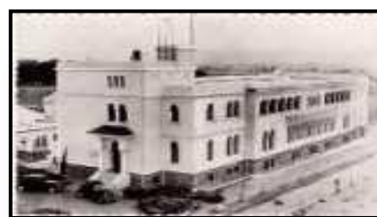
Figure 52 : institut agricole d'algerie à maison-carree
