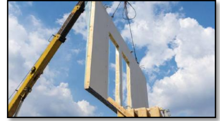
Figure 3 :préfabrication sur chantier
