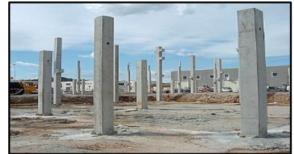
Figure 10 : Poteaux préfabriqués en béton
