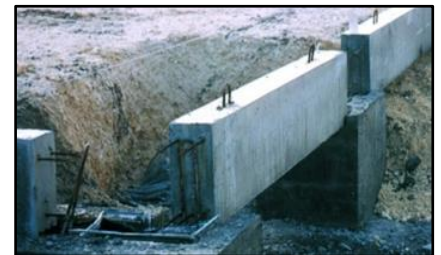
Figure 9 : longrine préfabriquée en béton
