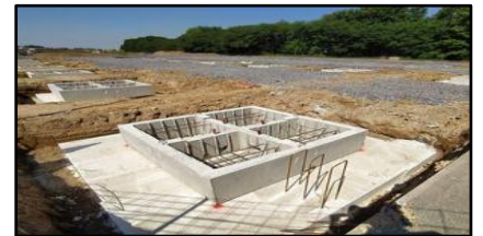
Figure 8 : fondation en béton préfabriqué
