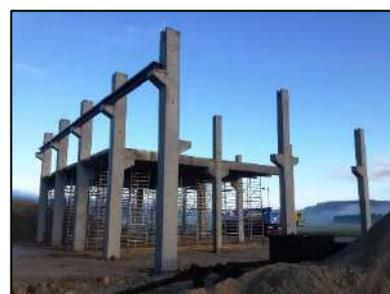
Figure 26 : Poteaux préfabriqués en béton. Source : [batiproduits.com](http://batiproduits.com)
