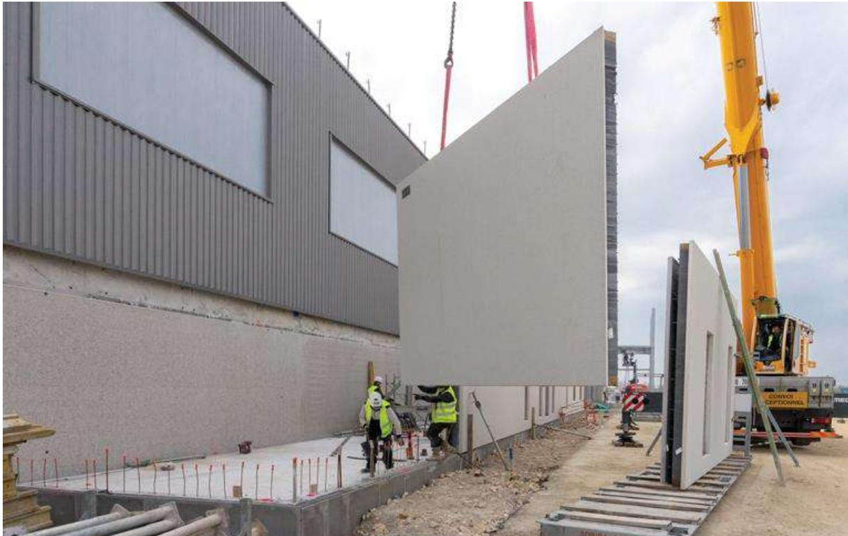
Figure13 : Panneaux de façade de hauteur d'un étage( Source : <https://www.acpresse.fr/soriba-unite-prefabrication-respectueuse/>)
