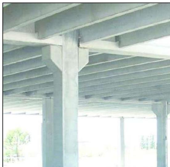
Figure30 : 4 Exemple de plancher nervuré. Source : [www.sturcturedacote.com](http://www.sturcturedacote.com)
