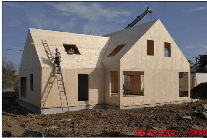
Figur27 : Exemple d'une construction en panneaux portants Source : <http://www.maisoneco.com/spip.php?article69>
