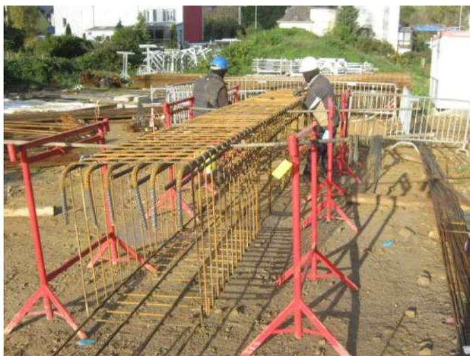
Figure 18 : Atelier de ferrailage de poutres BA avec tréteaux fixes. Source : [Découper, façonner et assembler les armatures en sécurité sur les chantiers - Prévention BTP \(preventionbtp.fr\)](#)
