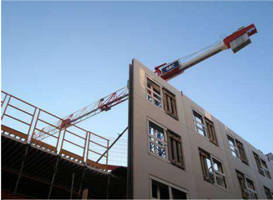
Figure14 : : Panneaux de façade de hauteur d'un étage Source : [www.uploads.gedimat.fr](http://www.uploads.gedimat.fr)
