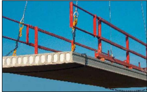
Figure 28 : Dalles alvéolées avec ses canaux longitudinaux typiques. Source : FEBEFLOOR 2020
