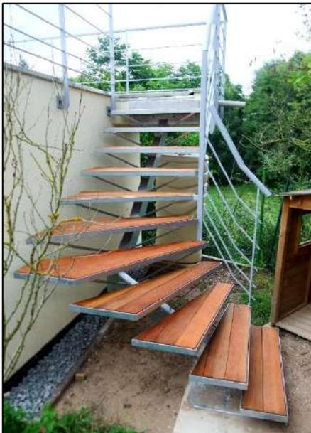
Figure31 : Escalier préfabriqué en acier
