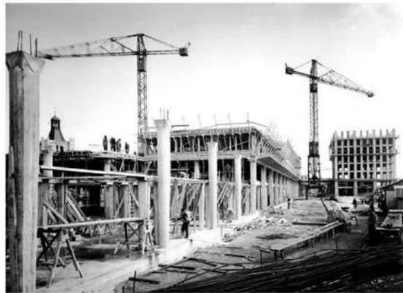
Figure8 : Système de préfabrication (source <https://gcpat.frideas> )
