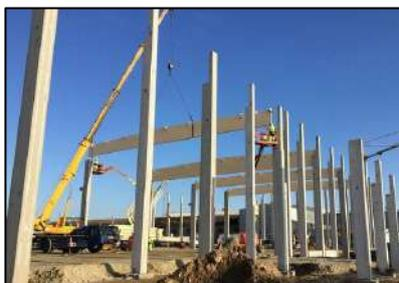
Figure 25 : Poteaux préfabriqués en béton. Source : [batiproduits.com](http://batiproduits.com)
