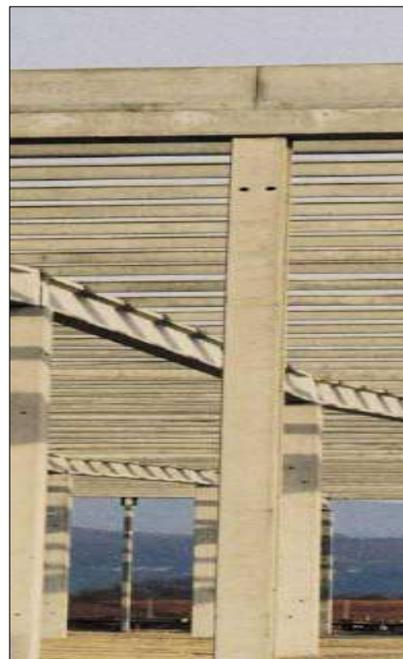
Figure 36 : poutre à inertie constante IC. Source : internet    Figure 37 : poutre à inertie variable IV. Source : internet
