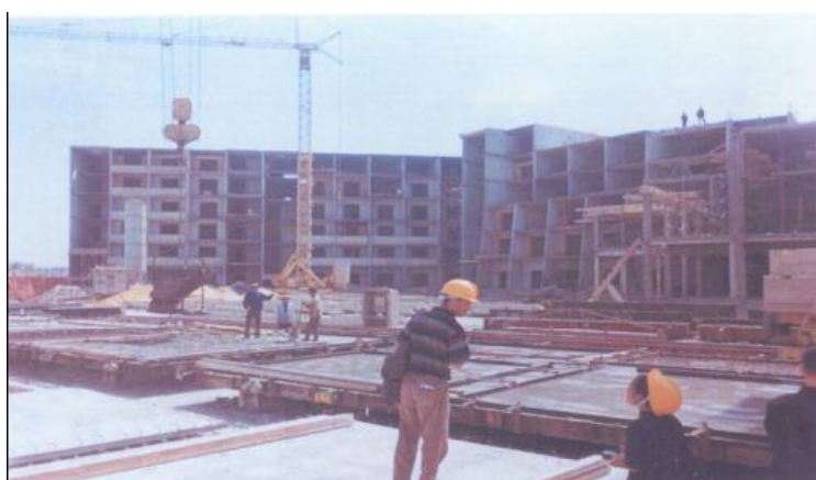
Figure 2 Atelier Précaire à l'air libre au pied de l'ouvrage à édifier 1
