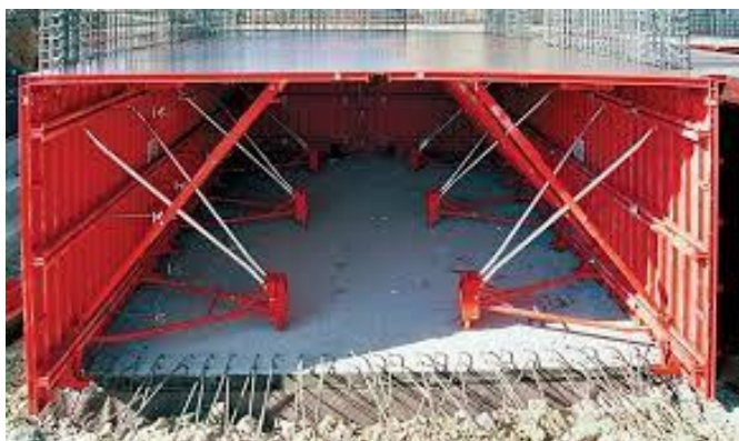
Figure 18 systèmes de coffrage industrialisé, le coffrage tunnel. (Facebook : Ingénieur du Suivi des Chantiers)
