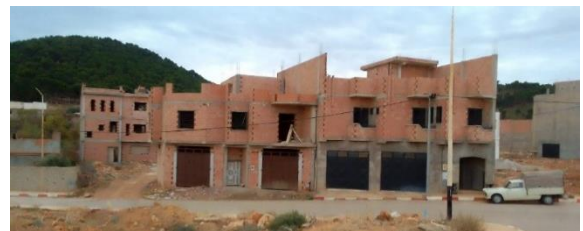
Figure 75 : vue de façade sud de terrain
