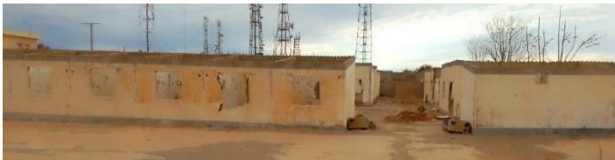
Figure 74 : vue de façade nord de terrain
