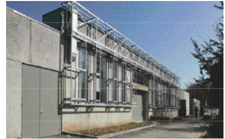
Figure 1: Préfabrication légère Des panneaux manutentionnés rhabillent un lycée Source: https://www.lemoniteur.fr/article/prefabrication-legere-des-panneaux-manuportables-rhabillent-un-lycee.904239
