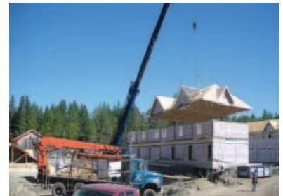
Figure 31: section de toiture
