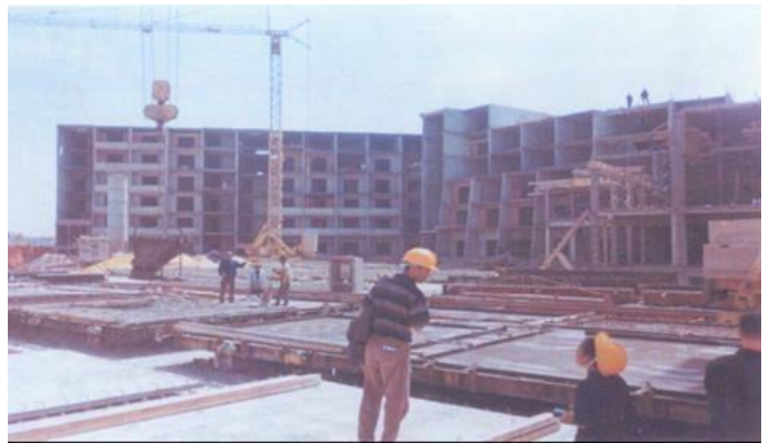
Figure 4: Atelier précaire à l'air libre au pied de l'ouvrage à édifier Source: https://www.technologuepro.com/genie-civil/Modulation-Constructions-Prefabrication/Chapitre1-Notion-prefabrication-construction.pdf p 4
