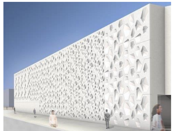
Figure 35: façade en GRC
