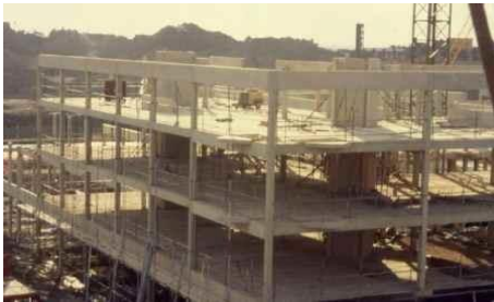
Figure 7: structure poteau poutre en Béton
