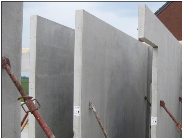
Figure 10 : Mur en béton armé (source : site www.batirama.com )
