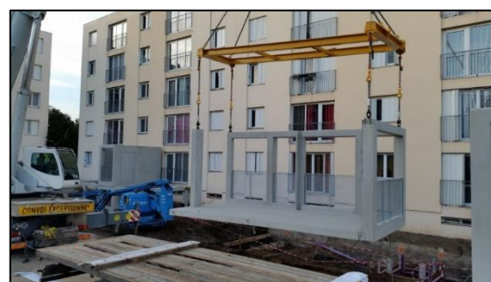
Figure 15 : Atelier foraine (source : site https://www.infociments.fr/le-renouveau-de-la-construction-hors-site )
