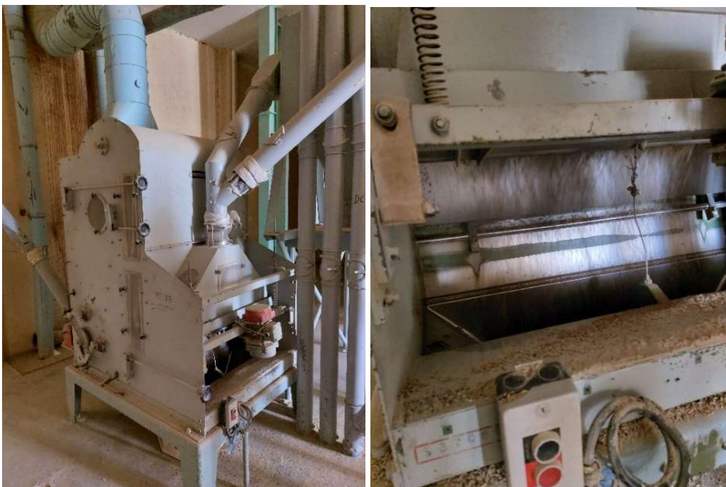
Figure 17 Processus de pré nettoyage
