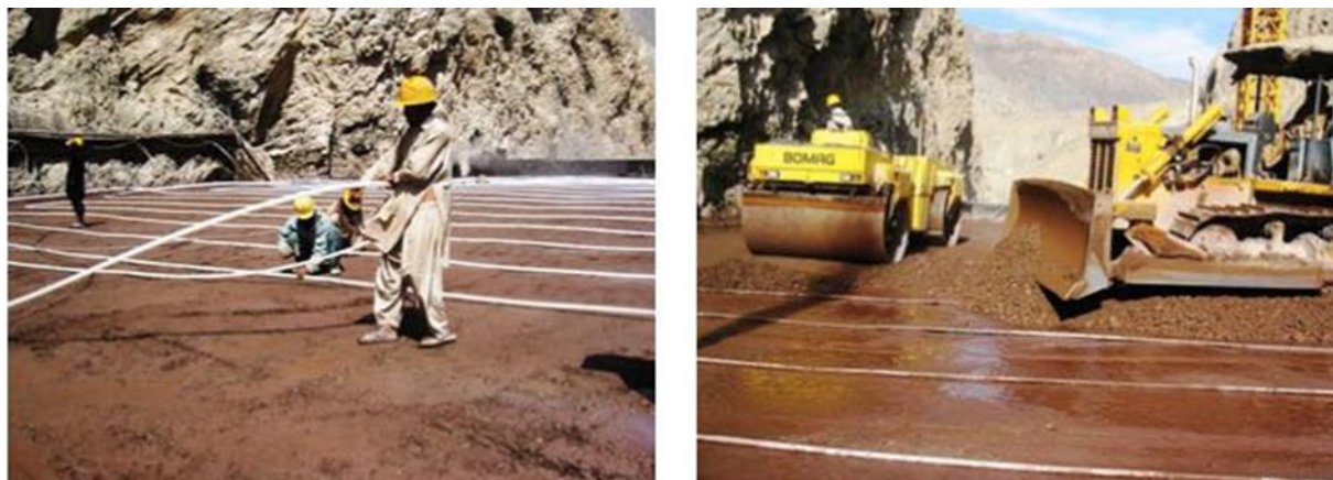
Figure 1. 17 : : Technique de post-refroidissement par l'intégration des systèmes de refroidissement (serpentin) [52].
