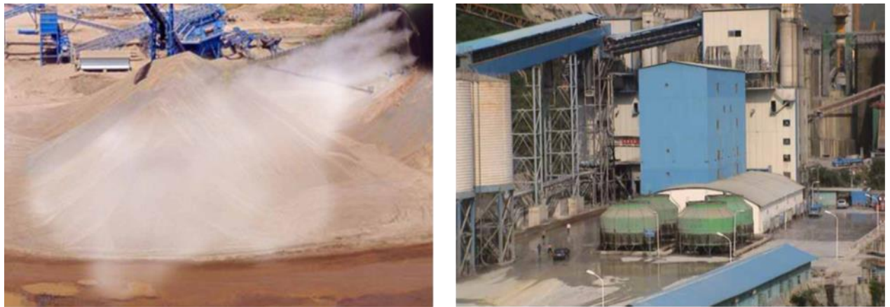
Figure 1. 18 : : Les techniques pré-refroidissement utilisées pour le control thermique : (a) refroidissement par l'injection de la vapeur d'eau sur les granulats ; (b) la chambre de la production des glaces pour la confection du BCR.
