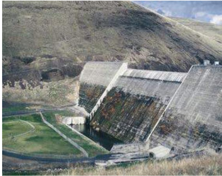
Figure 1. 3 : Barrage en BCR Willow-Creek au USA [19].
