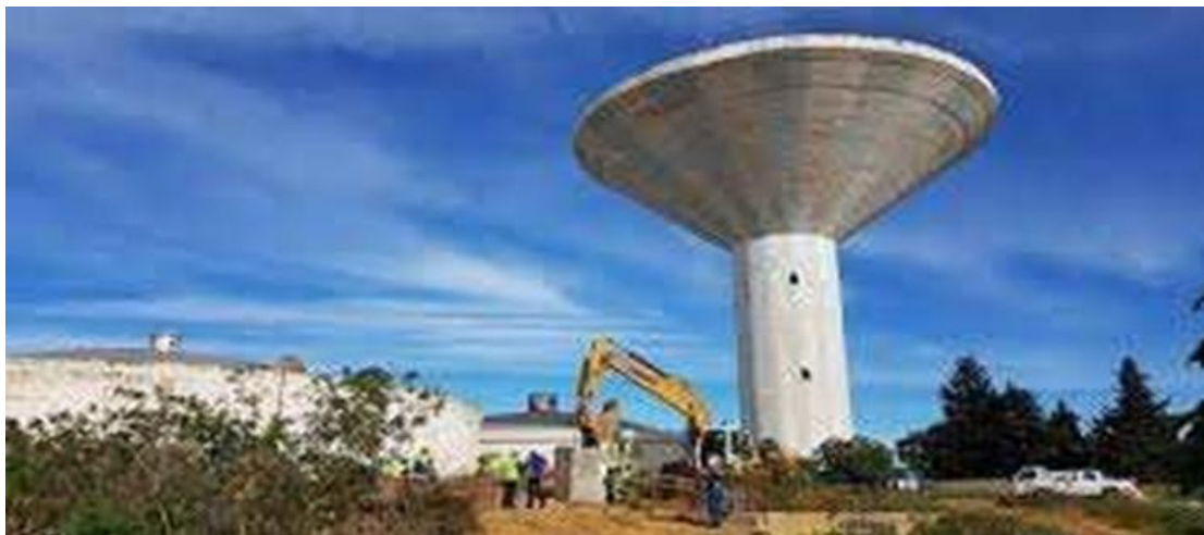
Figure I-9: Exemple de château d'eau [1]
