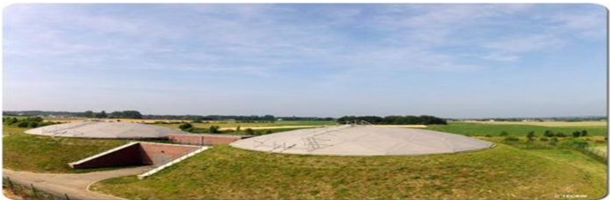
Figure I- 8: Exemple de réservoir d'eau
