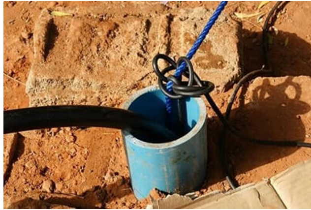
Figure I- 7: Exemple de forage d'eau [1]
