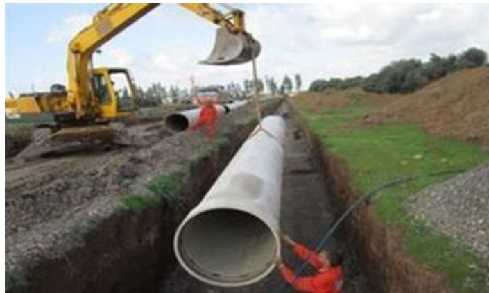
Figure I-2: Exemple d'adduction en eau potable réalisée par la SOGERHWIT [1]
