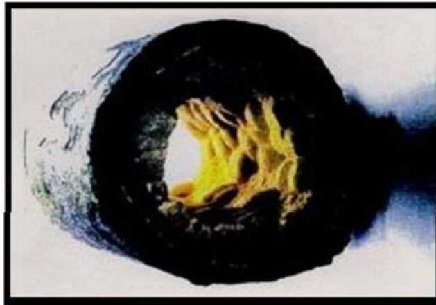
Fig. II.3 : Dépôt de Sulfates.
