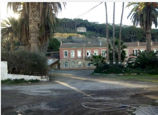
Bâtiment en bon état
