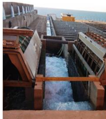
Fig63 : Filtres mécaniques tambours des deux plates
