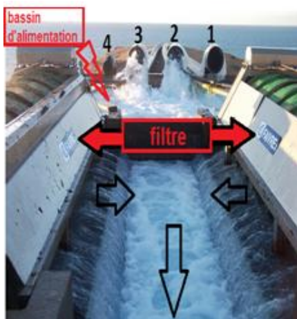
Fig63 : Filtres mécaniques tambours des deux plates
