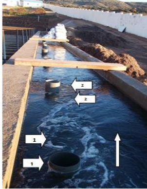
Fig57 :Pipes d'alimentation (1,1);(2,2)
