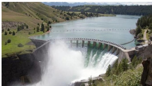
FIGURE 1.4 – Contrôle de chantiers par la CTH
