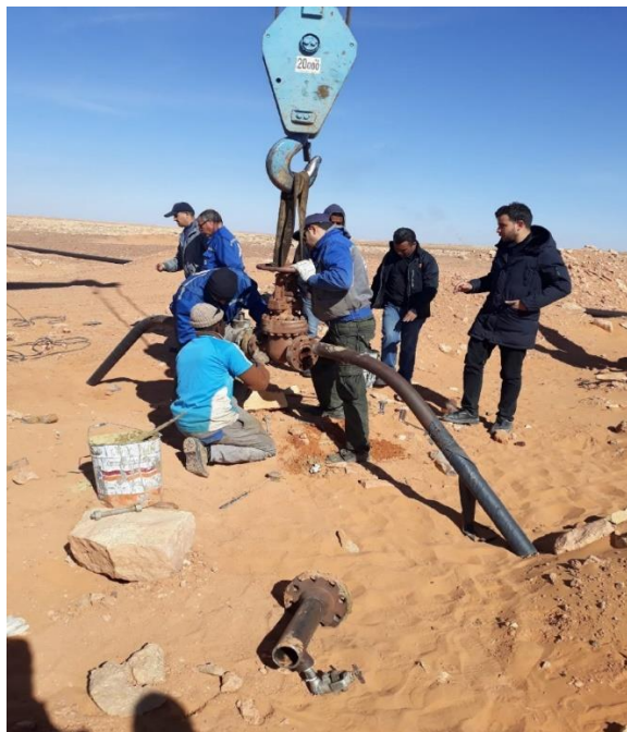
Travaux de l'emplacement de la 2 ème vanne
