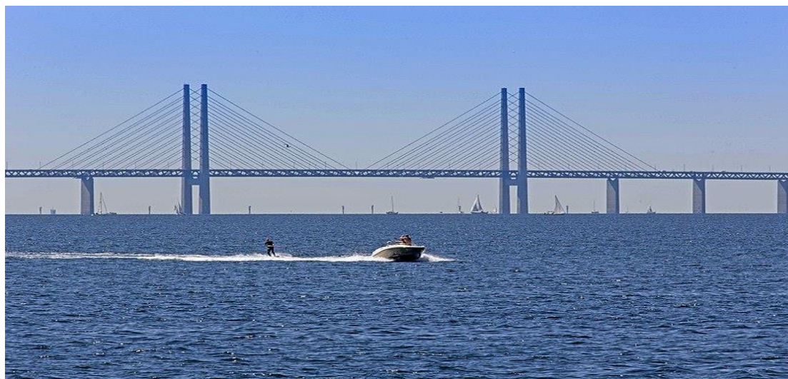
Figure I- 2: Pont haubané de l'Øresund entre le Danemark et la Suède. Portée de 490 mètres
