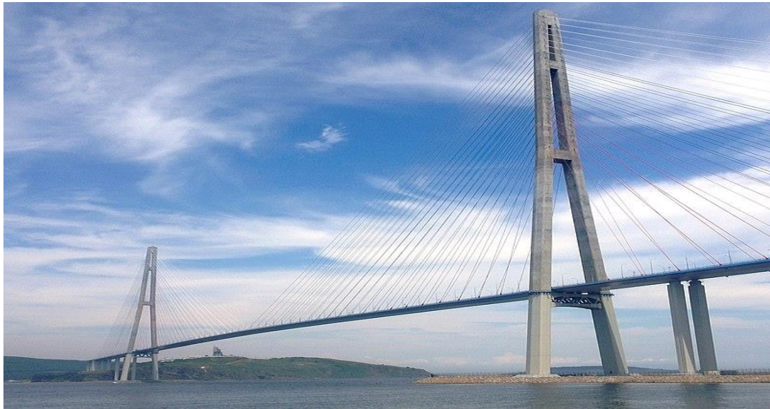
Figure I- 3:Le pont de l'île Rousski d'une longueur de 3 100 mètres ayant la plus longue portée au monde avec 1 104 m
