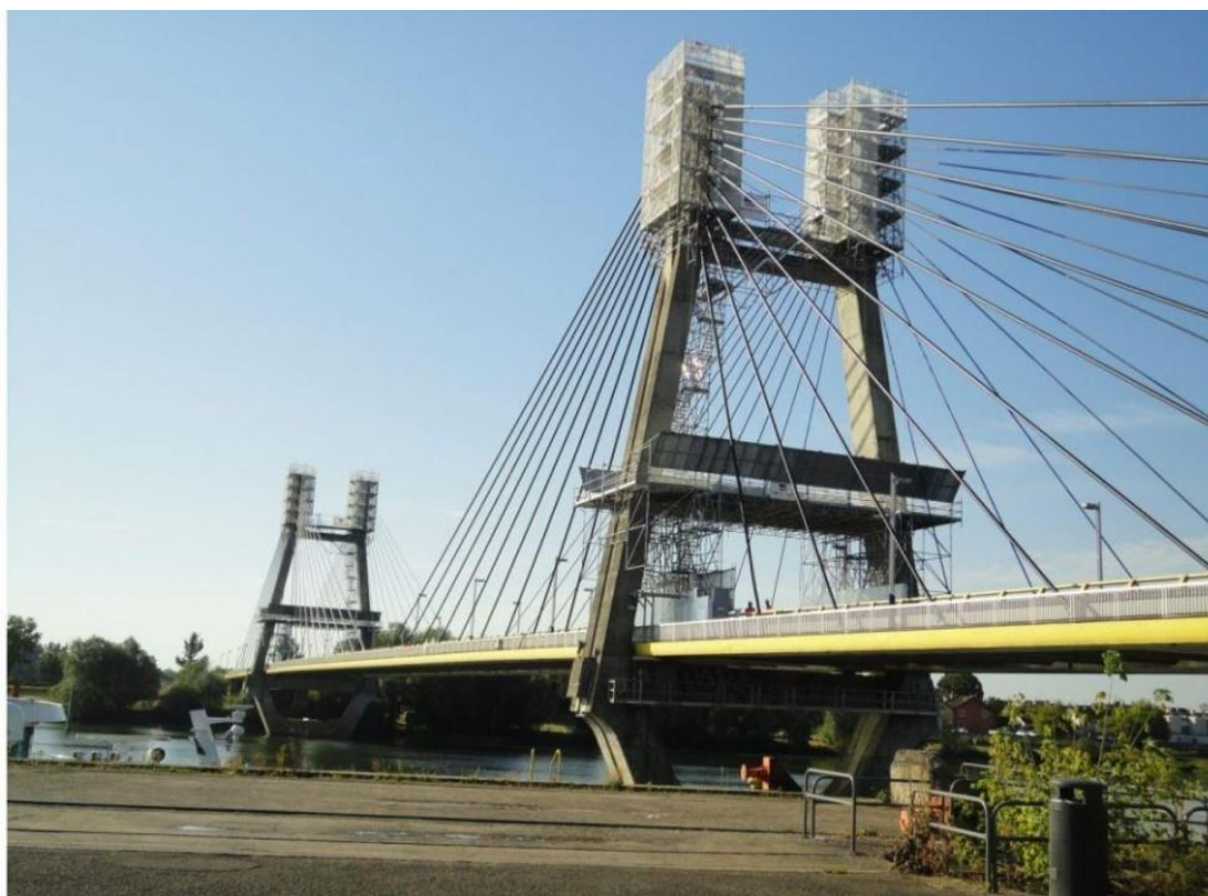
Figure I- 21: Réparation des haubans du pont de Bourgogne à Chalon sur Saône
