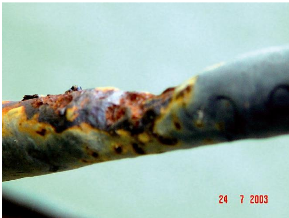
Figure II- 6: Zone de corrosion localisée sur un fil.
