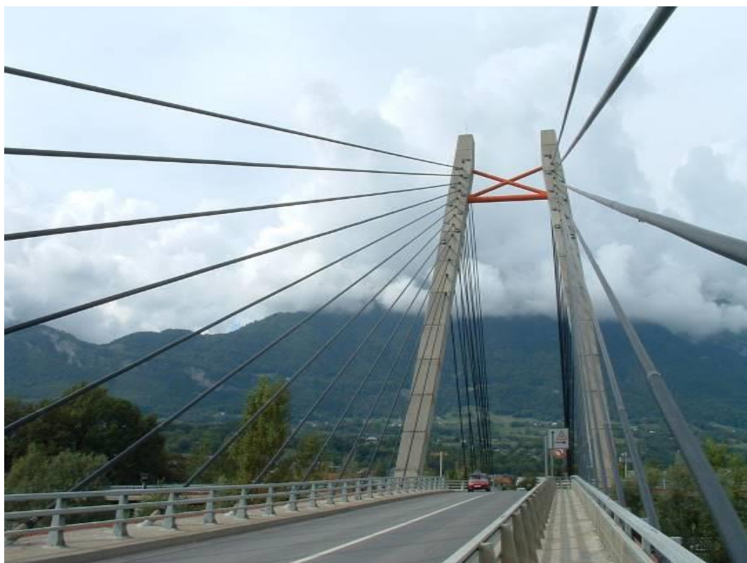
Figure I- 5: Pont de Gilly sur l'Isère
