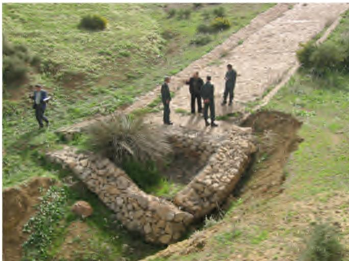
b) Seuil de correction torrentielle en terre inadapte en terrains marneux : déversoir endommagé par la force des eaux
