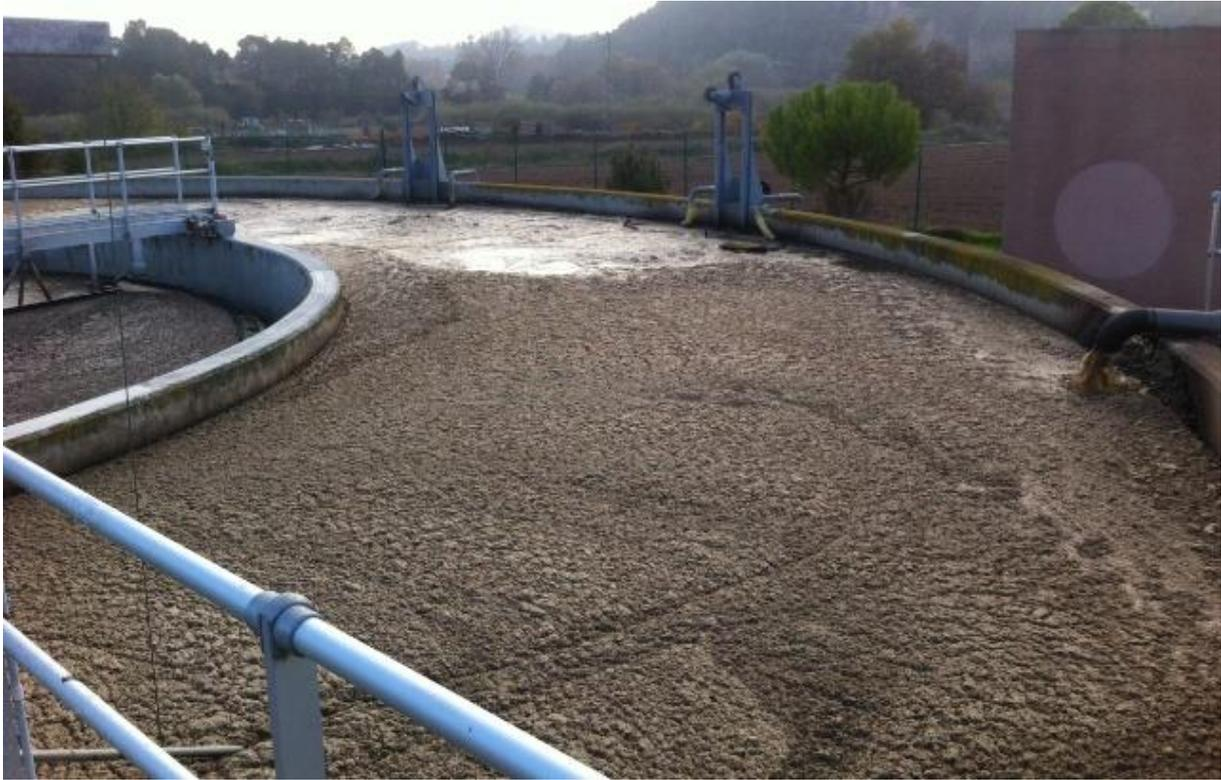
**Figure 9.** Phénomène du foisonnement en surface du clarificateur
