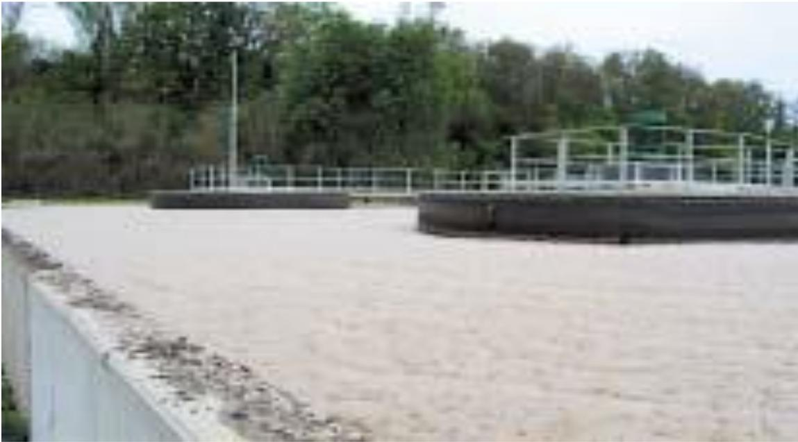
**Figure 8.** Mousse biologique en surface d'un bassin d'aération
