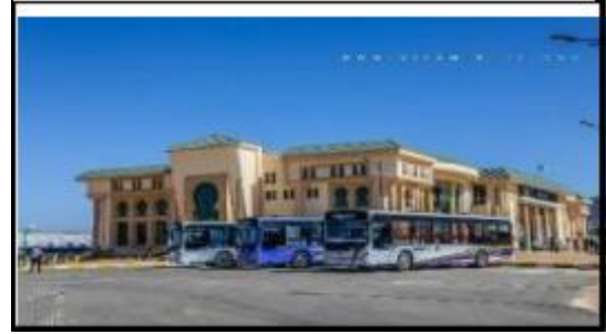
Figure25 : La nouvelle gare routière source : Vitamedz.com
