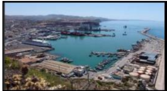
Figure 23 : Port de Ghazaouat source : portdeghezaouat
