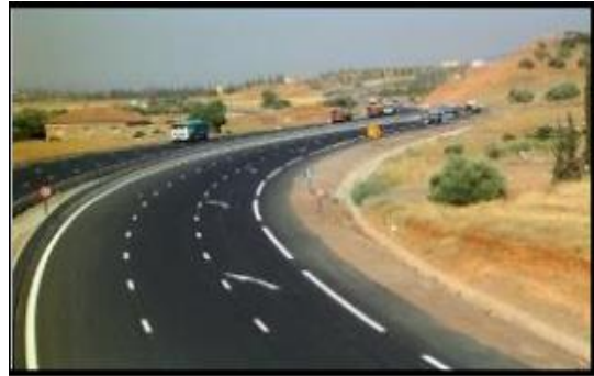
Figure 21 : Autoroute est-ouest source : algerie-focus.com
