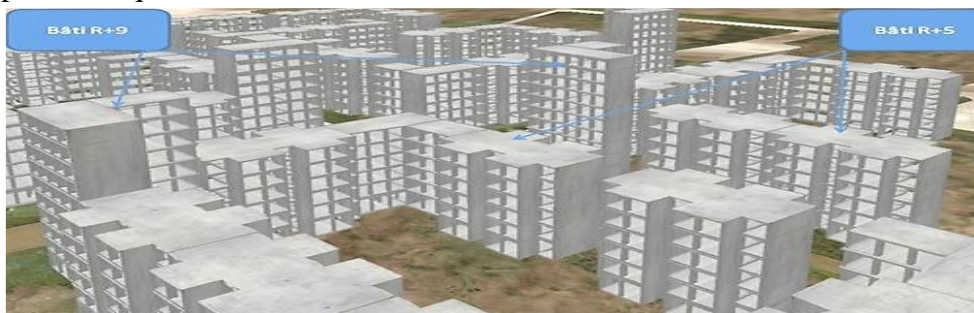
Figure 12 : construction des logements. Source : https://www.radioalgerie.dz/news/fr/tags/relogement?page=3
