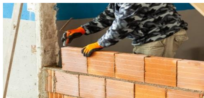
Figure 205 : mur en brique
