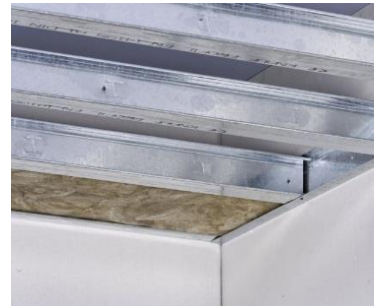
Figure 208 : faux plafond source : www.knauf.ch
