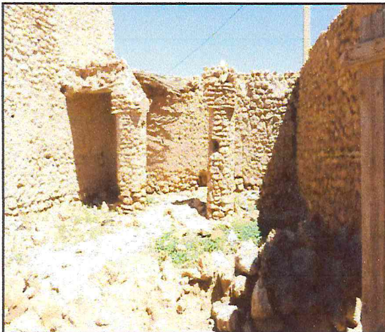
الصورة رقم (47): توضح الإسطبل بالنموذج رقم (1) بقصر أربوات التحتاني (عن الطالب)
