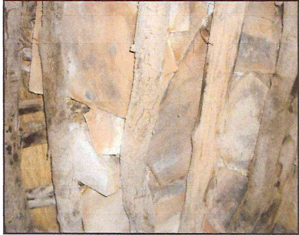
الصورة رقم (178): توضح استعمال الحجارة المسطحة في التسقيف (عن الطالب)
