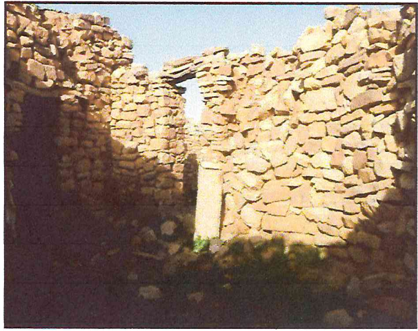
الصورة رقم (128): توضح مدخل وفناء المنموذج رقم (3) بقصر ستين (عن الطالب)
