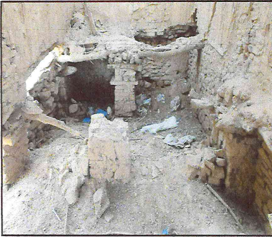
الصورة رقم (133): توضح مخزن النموذج رقم (4) بقصر ستين (عن الطالب)
