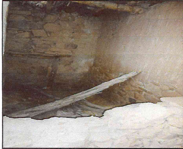
الصورة رقم (167): توضح مخزن بالنموذج رقم (5) بقصر مشرية (عن الطالب)
