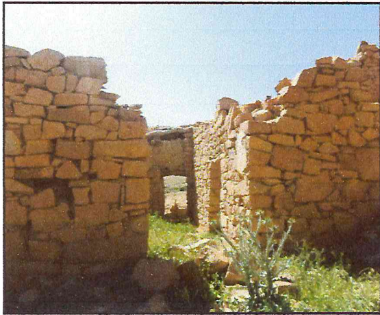
الصورة رقم (141): توضح واجهة النموذج رقم (1) بقصر مشرية (عن الطالب)
