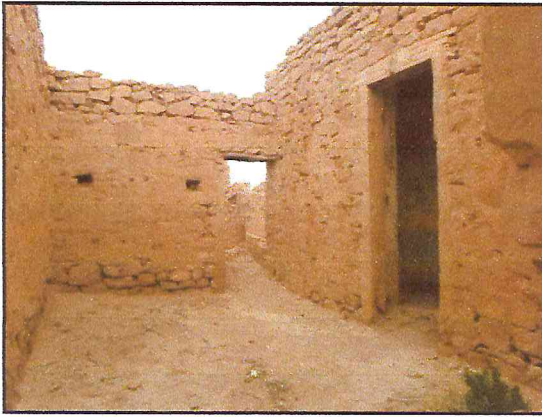
الصورة رقم (28): توضح مدخل وسقيفة ثانية بالطابق الأول للمنموذج رقم(3) بقصر الشلالة (عن الطالب)
