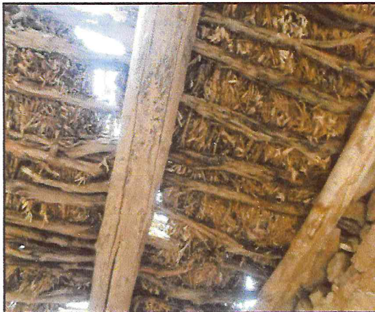
الصورة رقم (183): توضح استعمال عيدان الدفلة في التسقيف (عن الطالب)
