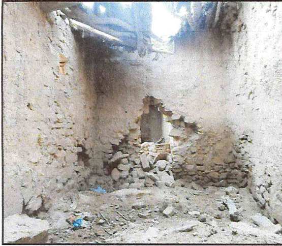
الصورة رقم (168): توضح غرفة نوم بالنموذج رقم (5) بقصر مشرية (عن الطالب)
