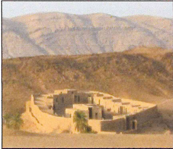
الصورة رقم (170): توضح منظر عام لقصر بنت الخص
