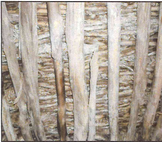
الصورة رقم (181): توضح استعمال خشب الصفصاف في التسقيف (عن الطالب)
