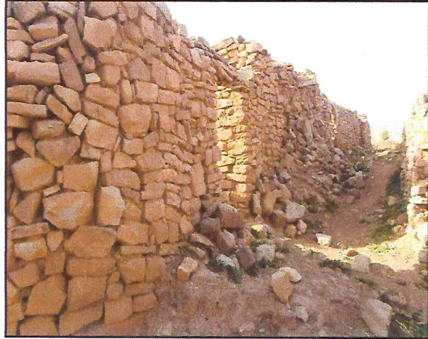
الصورة رقم (126): توضح واجهة شرقية للمنموذج رقم (3) بقصر ستين (عن الطالب)
