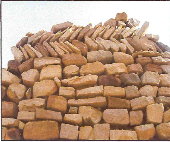
الصورة رقم (185): تقنية البناء بالمزج والسنبله (قصر ستيتن)
