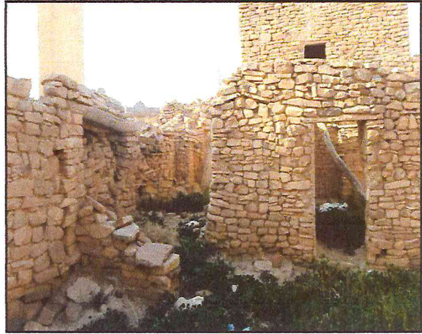
الصورة رقم (132): توضح سقيفة وفناء النموذج رقم (4) بقصر ستين (عن الطالب)
