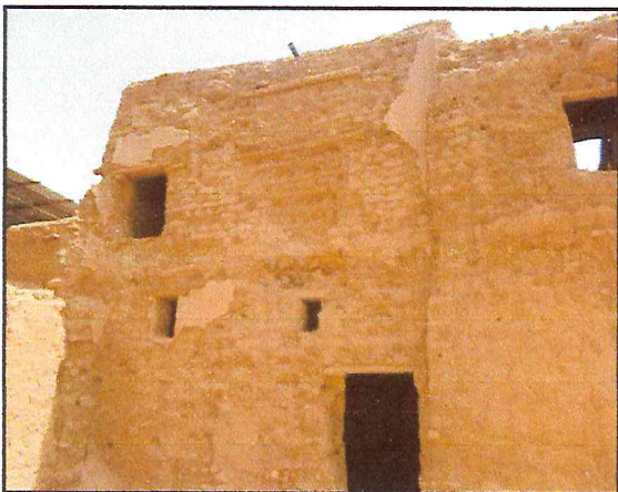
الصورة رقم (6): توضح واجهة النموذج رقم (1) بقصر بوسمغون (عن الطالب)
