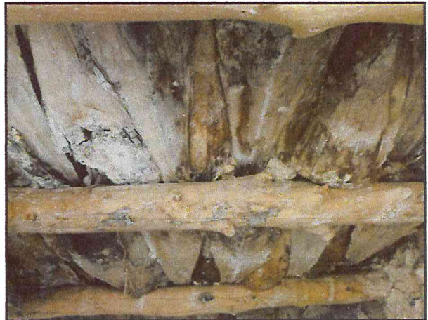
الصورة رقم (182): توضح استعمال الكرناف في التسقيف (عن الطالب)
