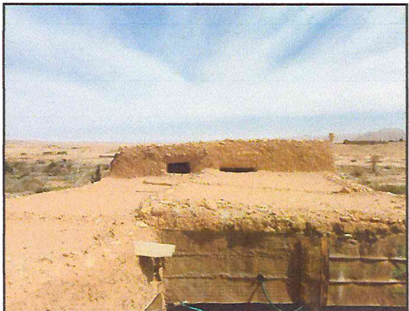
الصورة رقم (100): توضح سطح النموذج رقم (4) بقصر الغاسول (عن الطالب)
