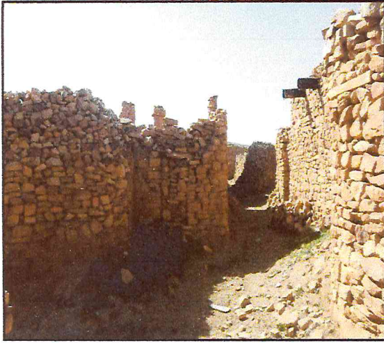
الصورة رقم (121): توضح واجهة شرقية للمنموذج رقم (2) بقصر ستين (عن الطالب)
