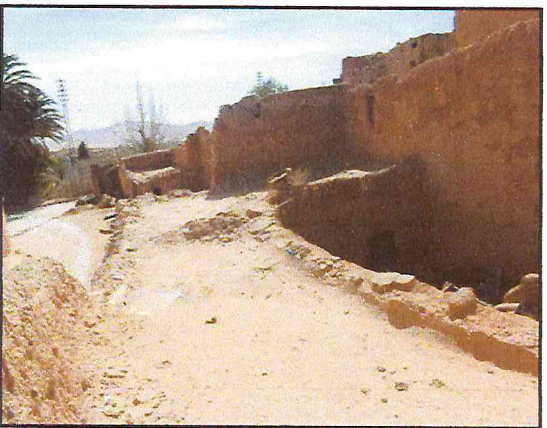
الصورة رقم (107): توضح سطح النموذج رقم (5) بقصر الغاسول (عن الطالب)
