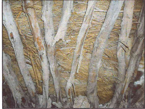
الصورة رقم (184): توضح استعمال الرتم في التسقيف (عن الطالب)
