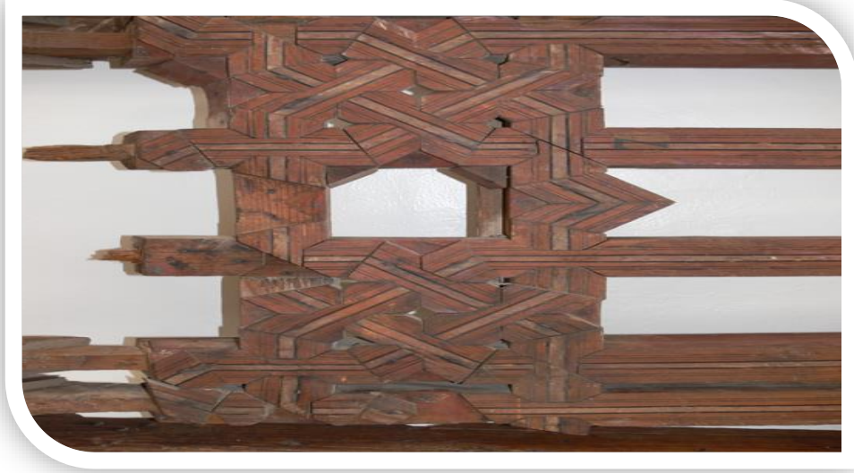
الصورة 27: تقنية التجميع والتعشيق
