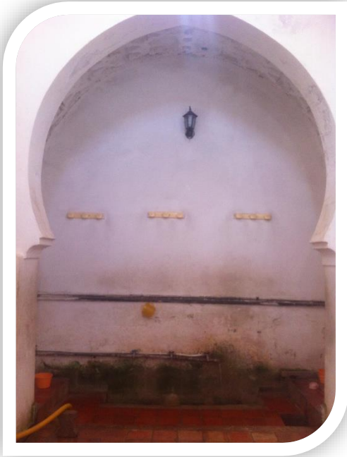
الصورة 22: بلل الرضية وخروج الملاط الذي يربط بين بلاطات الأرضية
