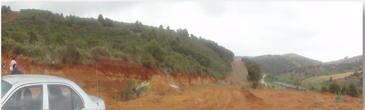
Photo N°9 : Construction routière au niveau de la station de Ouled yousef. (Le 19-04-2011)
