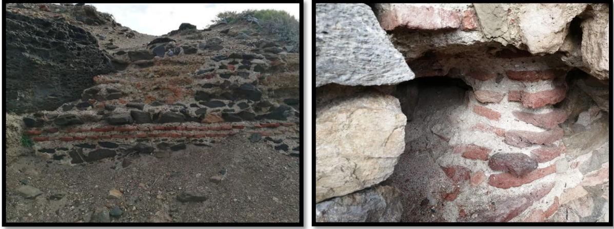
لوحة رقم 05: تمثل تقنية البناء غير منتظمة في القلعة و برج البحري
