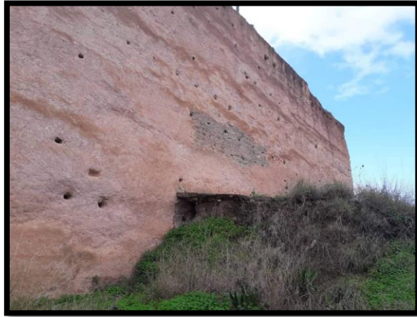
صورة رقم 02: تمثل جدران القلعة المبنية بمادة الطابية
