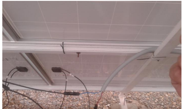
Figure 2.2 : Mauvais câblage des modules
