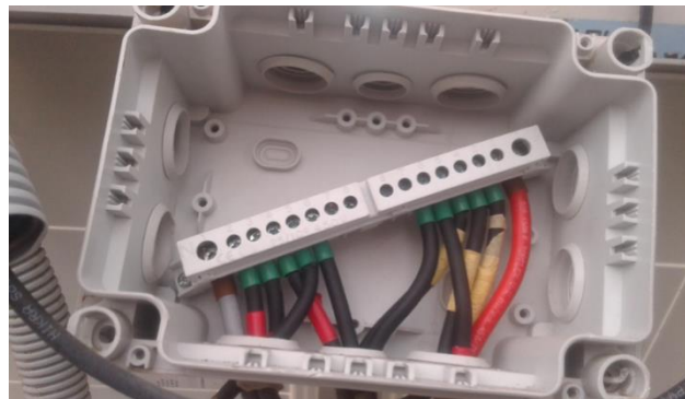
Figure 2.3 : Inversion des liaisons de sortie
