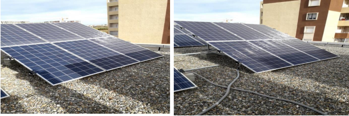
Figure 2.4 : Ombrage partiel des panneaux solaires
