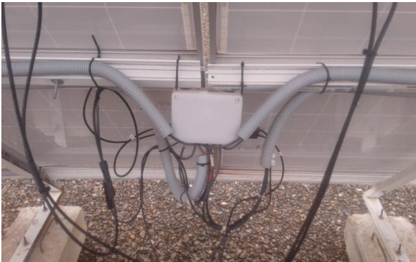
Figure 2.2 : Mauvais câblage des modules
