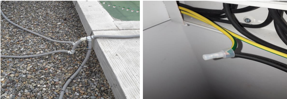
Figure 2.5 : Mauvais câblage
