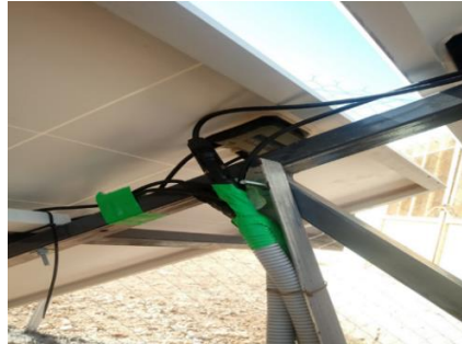
Figure 2.8 Module mal fixé et module cassé
