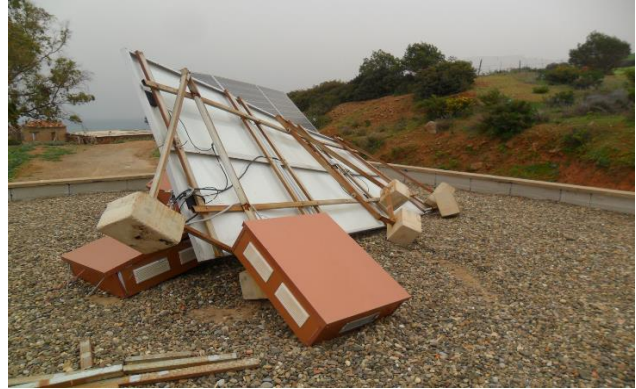
Figure 2.1 : Mauvaise résistance mécanique des supports des modules
