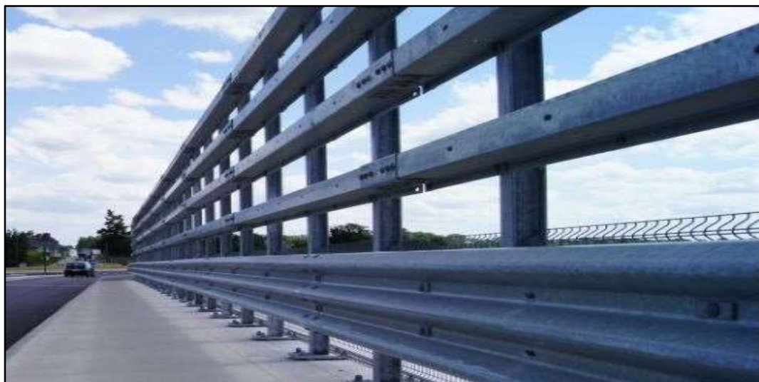
Figure 63: Les garde-corps après la pose
