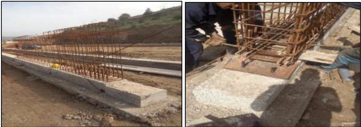
Figure 48: Mise en place du ferrailage de la poutre précontrainte
