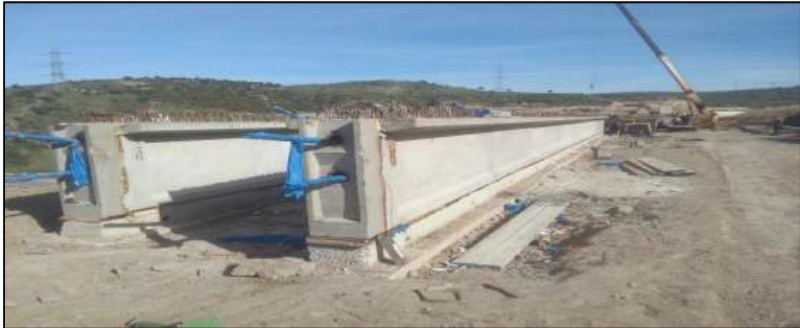
Figure 51: Poutre précontrainte après décoffrage
