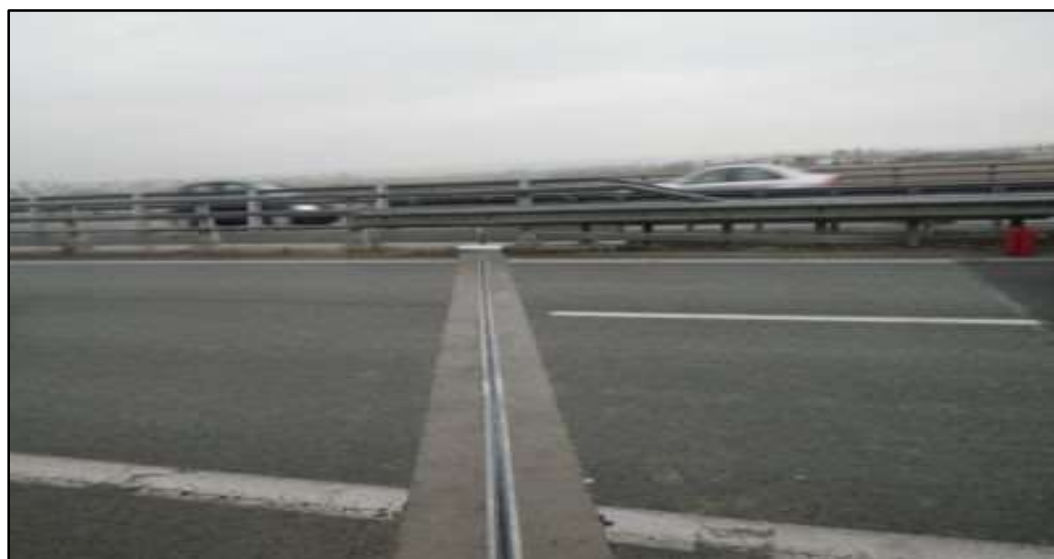
Figure 64: Le joint de la chaussée après la pose
