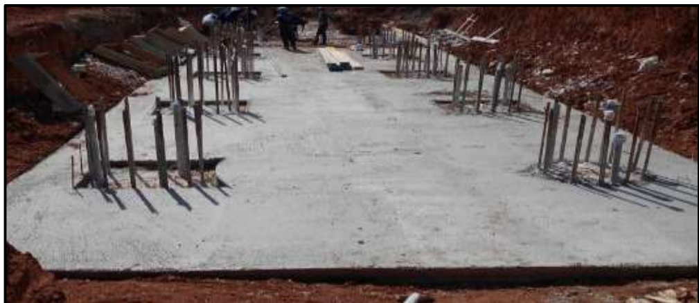
Figure 35: Béton de propreté de la semelle sur pieux
