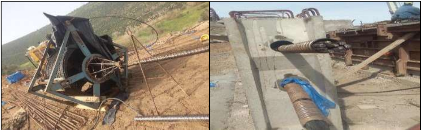
Figure 52: L'enfilage des aciers précontraints
