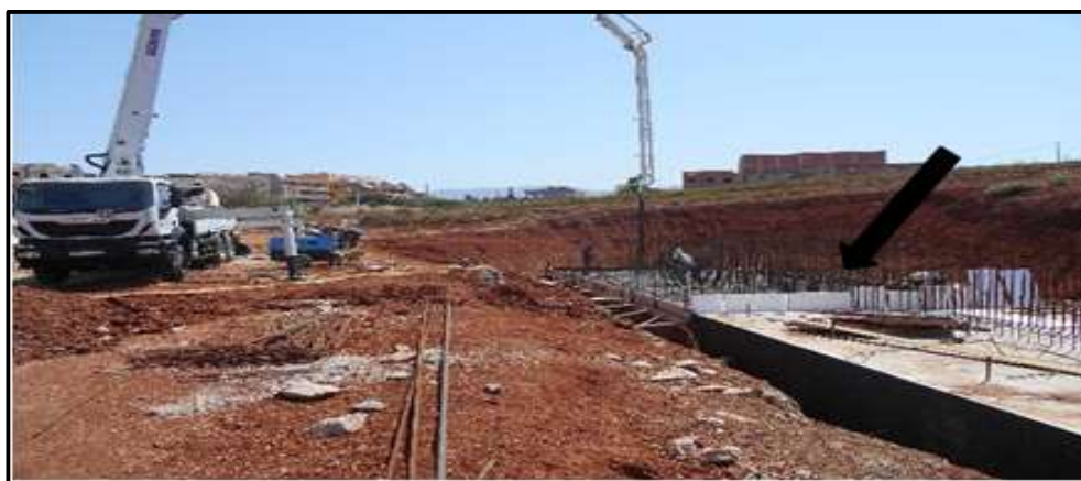
Figure 38: Coulage de la semelle
