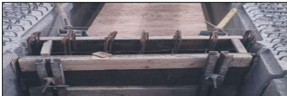
Figure 54: Coffrage des entretoises
