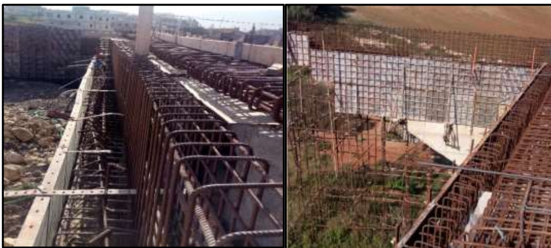
Figure 42: Ferrailage et coffrage de mur de garde-grève et mur en retour
