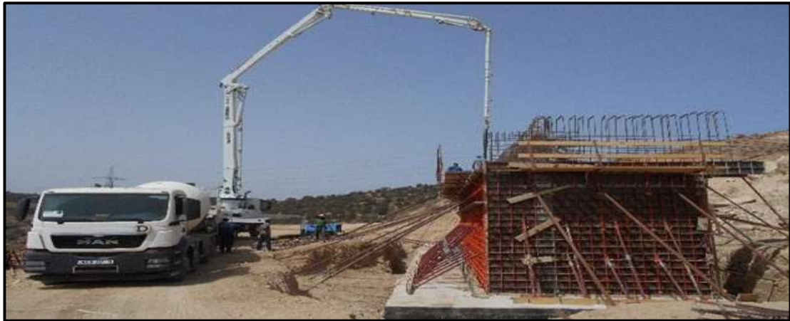
Figure 41 : Bétonnage de la culée
