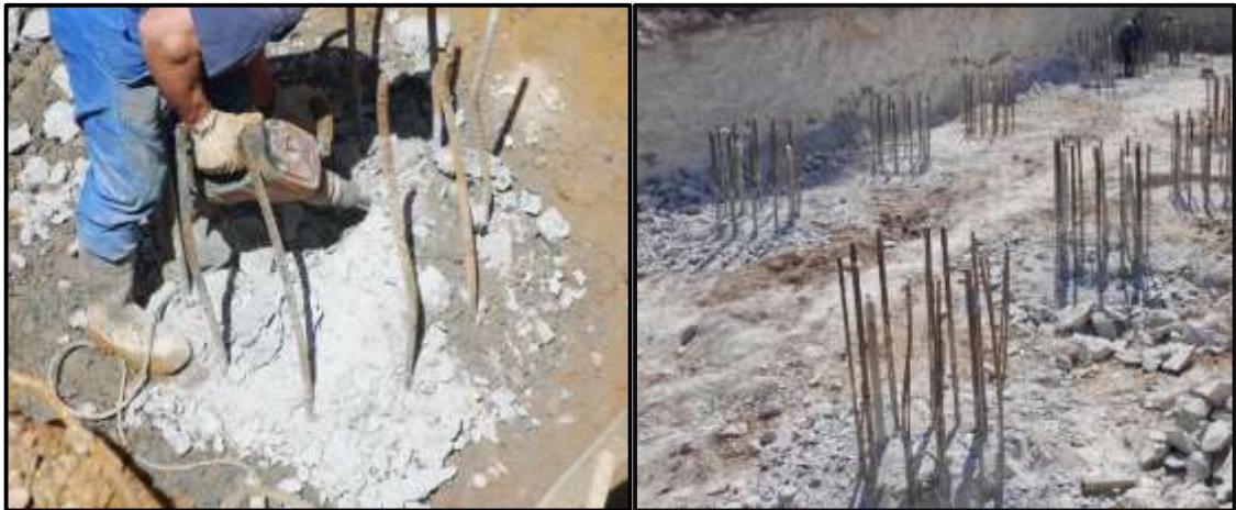
Figure 34: Le recepage des pieux
