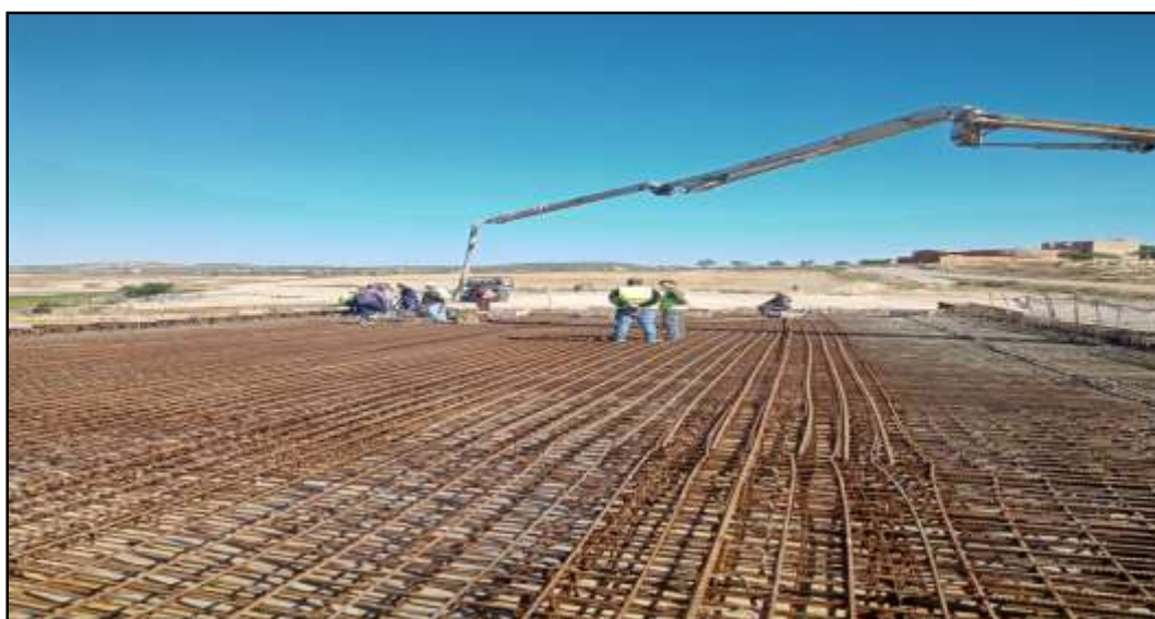
Figure 70: réalisation de la dalle
