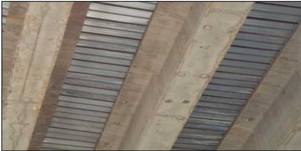
Figure 69 : pose de TN 40
