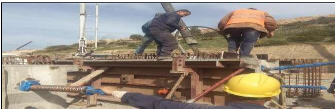
Figure 50: Coulage de la poutre précontrainte
