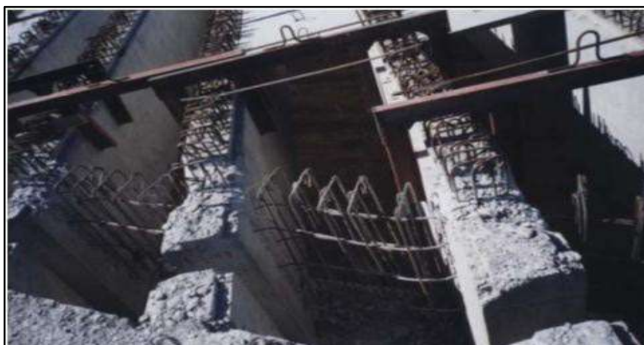
Figure 67: Ferrailage d'entretoise
