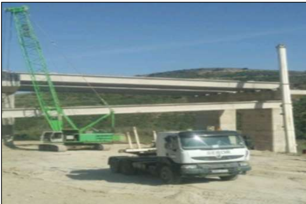
Figure 66: La pose de la poutre précontrainte
