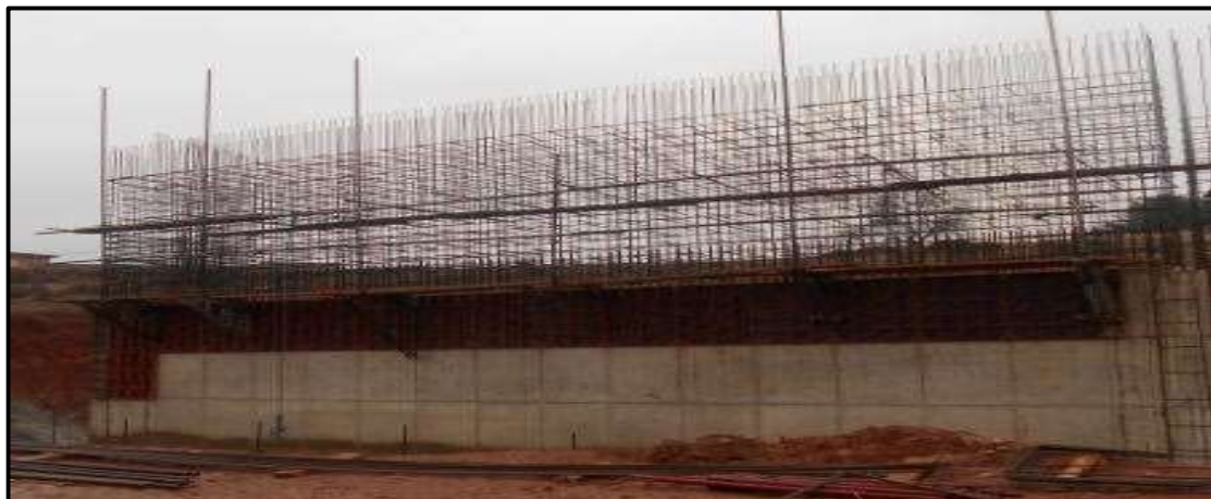
Figure 39: Réalisation de ferrailage de la culée C1-PK11+320
