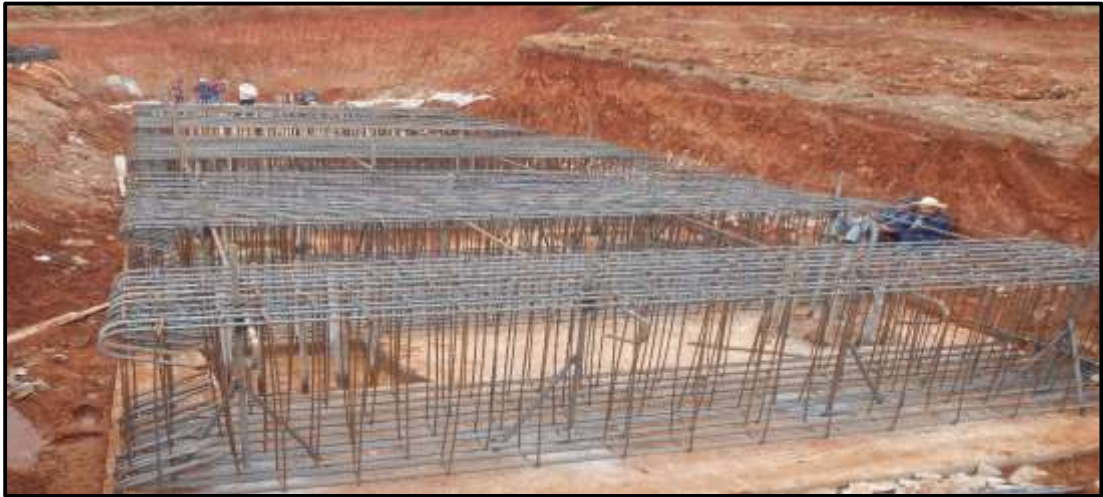
Figure 36: Mise en place des armatures de la semelle
