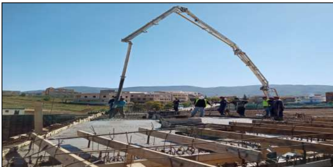
Figure 71: bétonnage de la dalle 1 gauche
