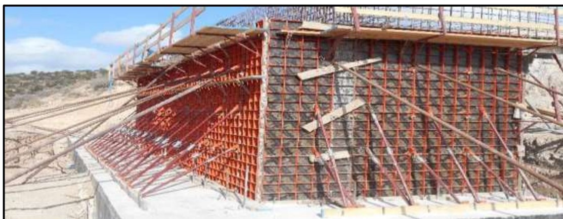
Figure 40: Coffrage de la culée
