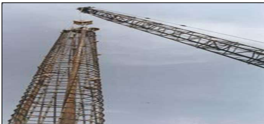
Figure 31: Mise en place du ferrailage
