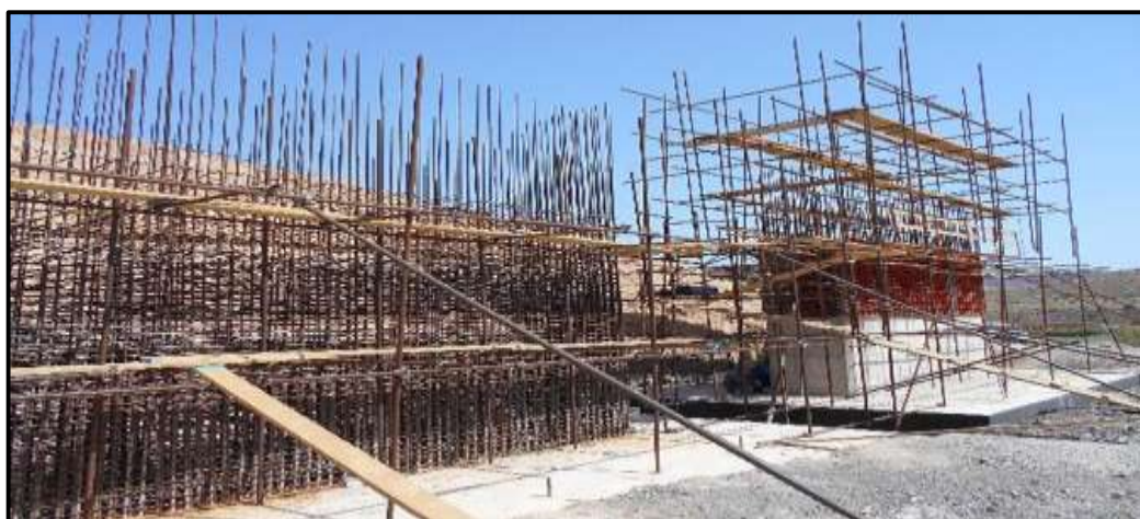
Figure 43: Réalisation de ferrailage et le coffrage de la pile P2-PK11+320
