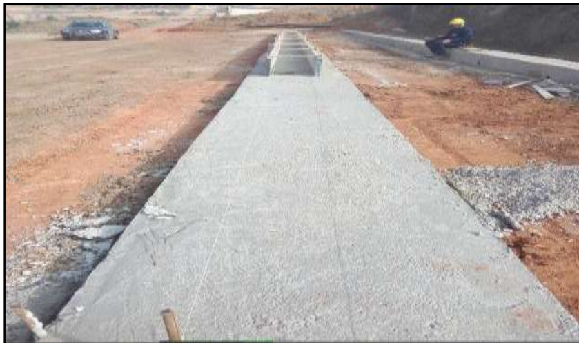
Figure 46: Pose du béton de propreté
