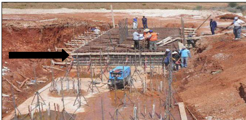
Figure 37: Coffrage de la semelle
