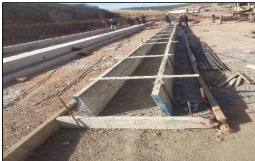
Figure 47: Réalisation du socle de poutre
