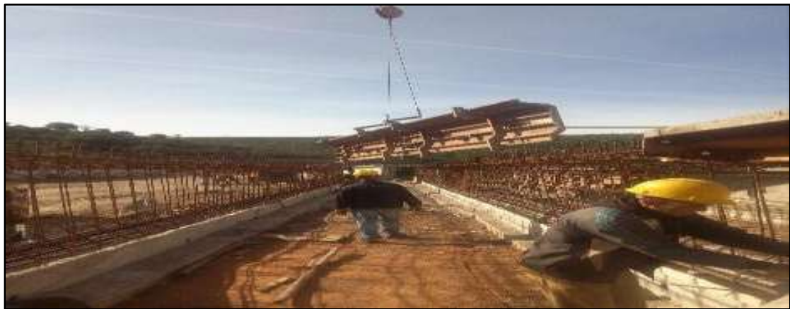
Figure 49: Pose du coffrage de la poutre précontrainte
