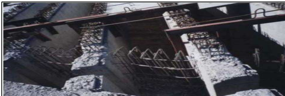
Figure 53: ferrailage des entretoises
