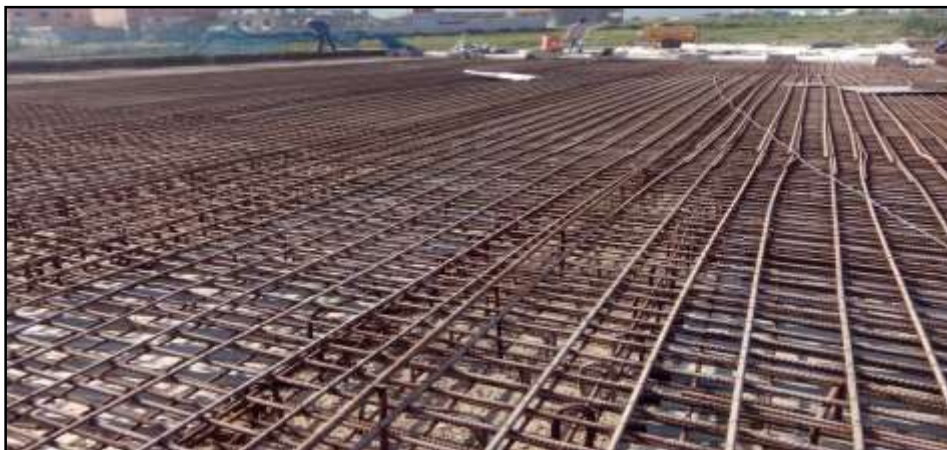
Figure 57: Ferrailage de la dalle du pont
