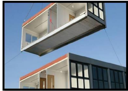
Figure N°17 constructions par cellules
