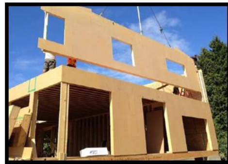
Figure N° 16 Panneaux de façades préfabriquées
