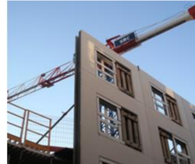
Figure N°01 Construction préfabriquée en béton armé
