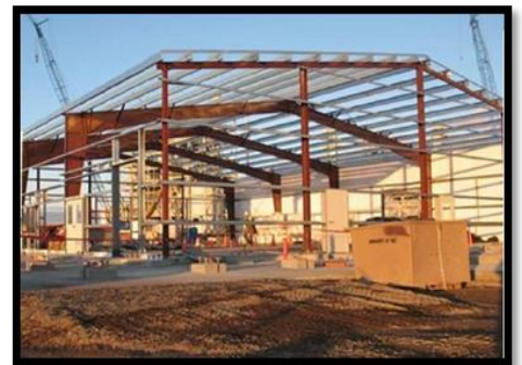
Figure N°12 La construction par portiques
