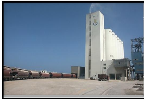
Figure N°37 silo de port
