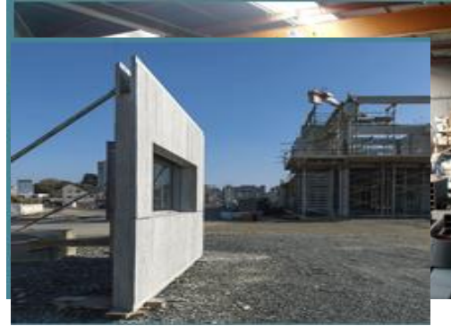
Figure N° : 08 La préfabrication légère
