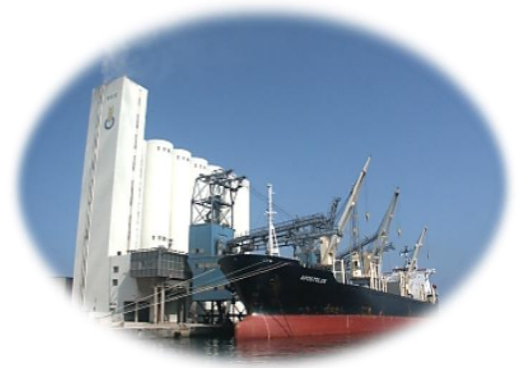
Figure N°44 silo de port
