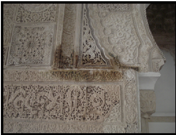
FISSURATION DES STUCS
