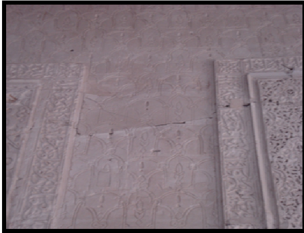
FISSURATION DES STUCS
