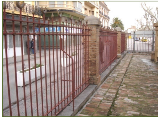
Revêtement de sol en carreaux de briques pleines posées à plat..
