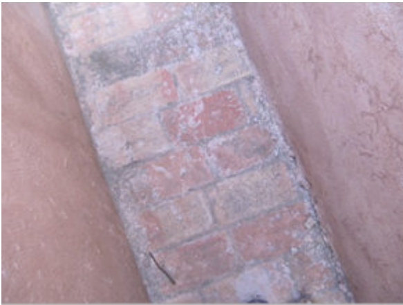
La plate-forme est revêtue de briques pleines.
