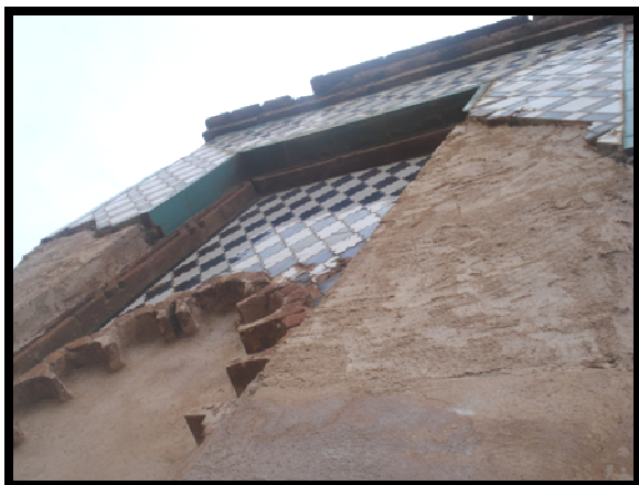
DEGRADATION DU ZELLIDJ DU MINARET
