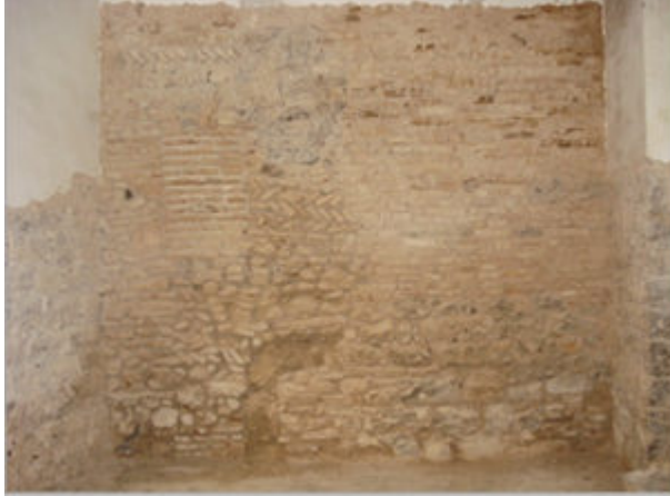
Maçonnerie hétéroclite suite aux multiples remaniements.
