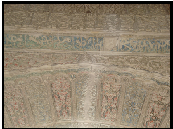
FISSURATION DES STUCS
