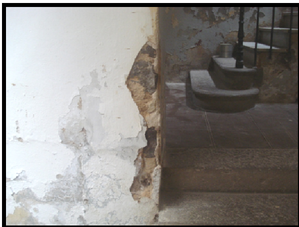
DEGRADATION DES STUCS
