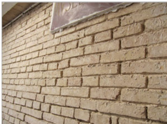
Maçonnerie en brique pleine (type colonial) posées à plat.
