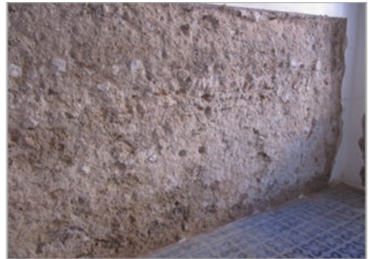
Mur porteur réalisé en maçonnerie banché (pisé)
