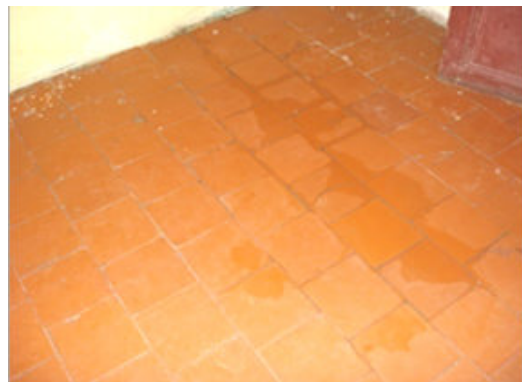
Revêtement de sol par des carreaux en ciment.
