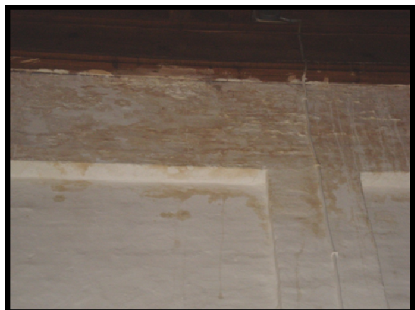
DEGRADATION DES STUCS
