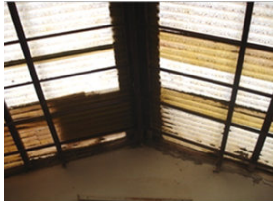
Couverture recouverte par du plastique ondulé translucide.
