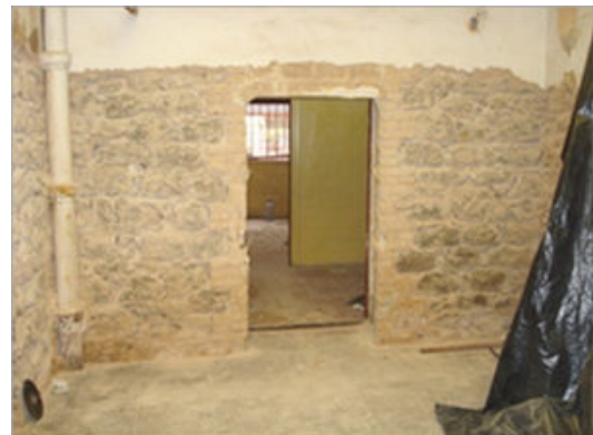
Maçonnerie en pierres bleu de taille avec des assises régulières.
