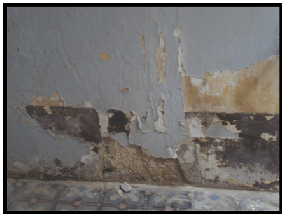
DEGRADATION DES ENDUITS
