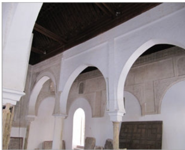
Arcs outrepassés légèrement brisés réalisés en brique
