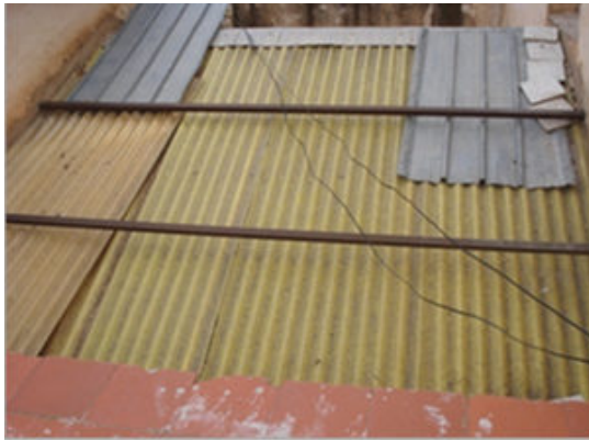
Toiture composée par une charpente mixte (métal – bois)
