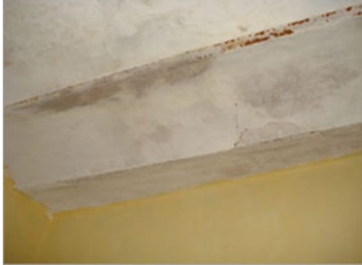
Plancher à voûtains des niveaux étage et terrasse.
