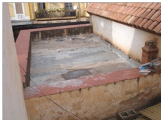
Revêtement de sol à l'origine en carreau de ciment.
