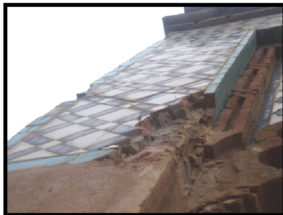
DEGRADATION DU ZELLIDJ DU MINARET
