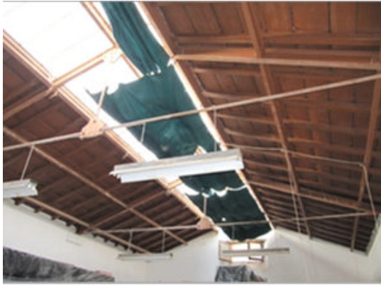
Toiture composée par une charpente mixte (métal – bois)
