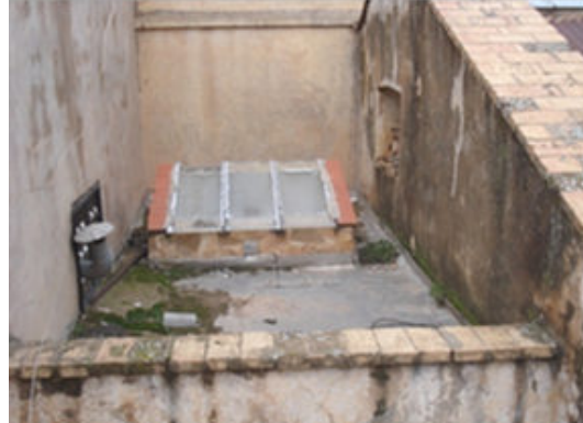
Planchers terrasses percés par des verrières.
