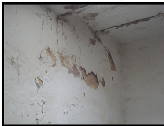
DEGRADATION DES ENDUITS
