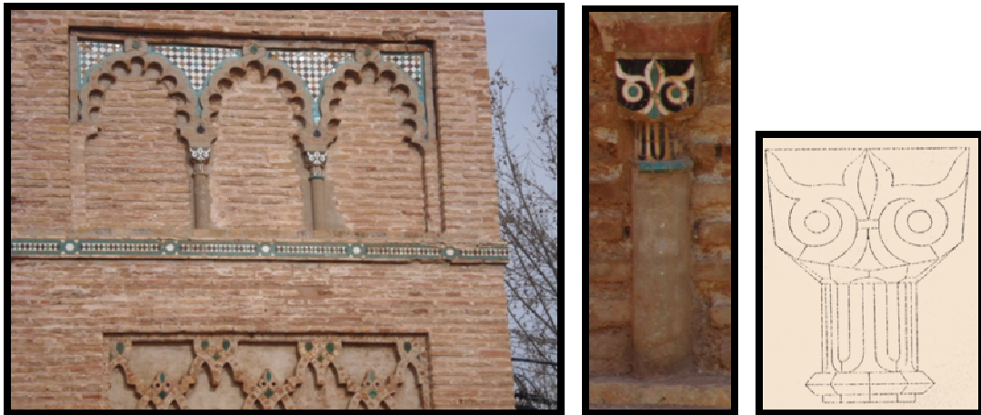
Trois arcades lobées semblablement posées sur des colonnettes Revêtus par la mosaïque de la faïence
