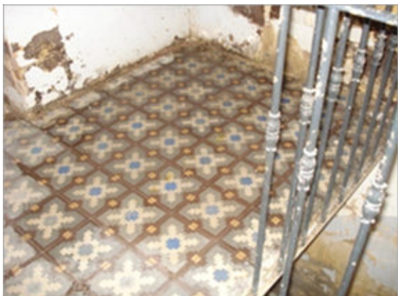
Revêtement de sol par des carreaux en ciment décorés.
