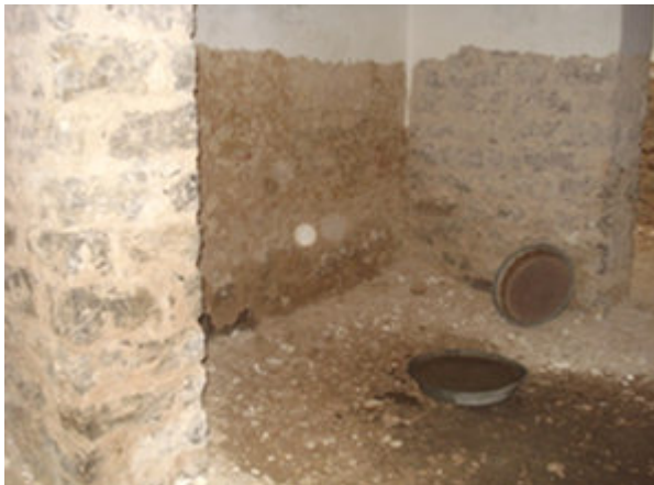
Maçonnerie des pilastres en pierres bleu de taille.
