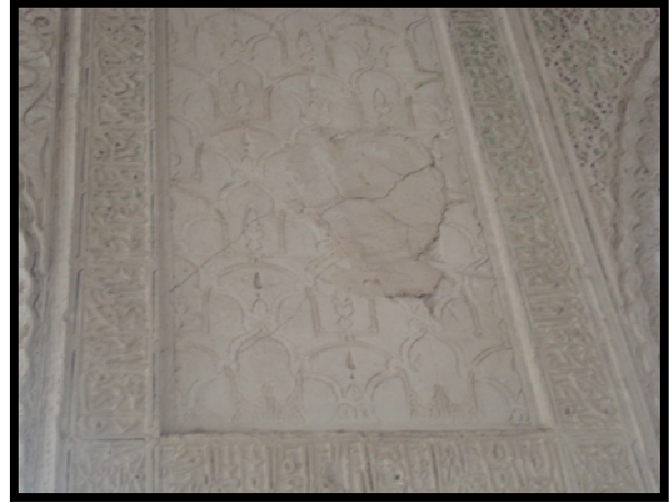
FISSURATION DES STUCS
