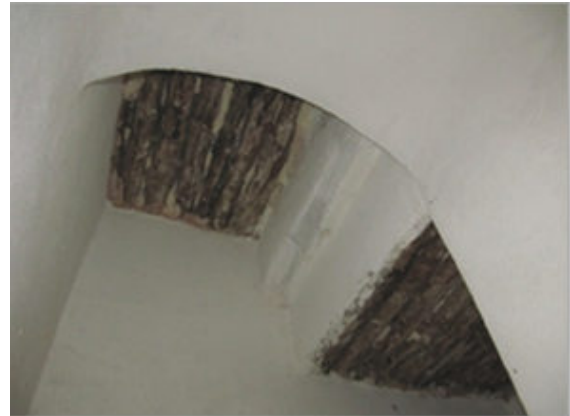
Les premières volées d'escaliers reposent sur une structure en bois.
