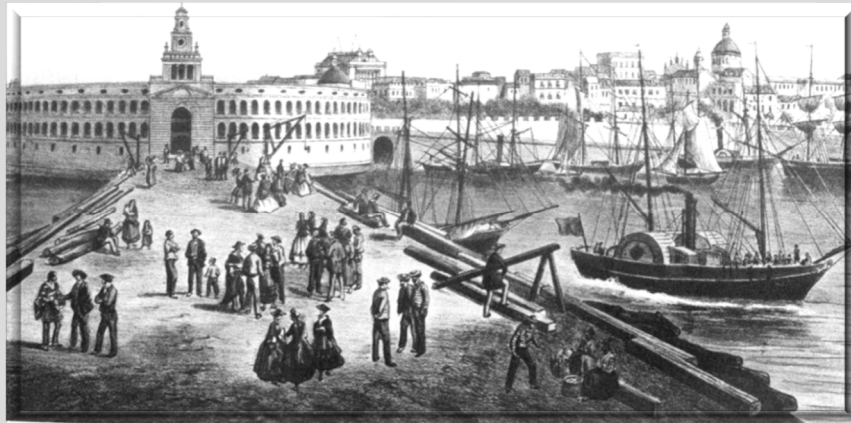
Figura 36. Edificio de la Aduana de Charcas (siglo XVIII)
