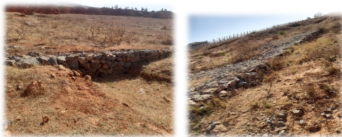
Photos 15 et 16 : seuil en gabion en bon état
