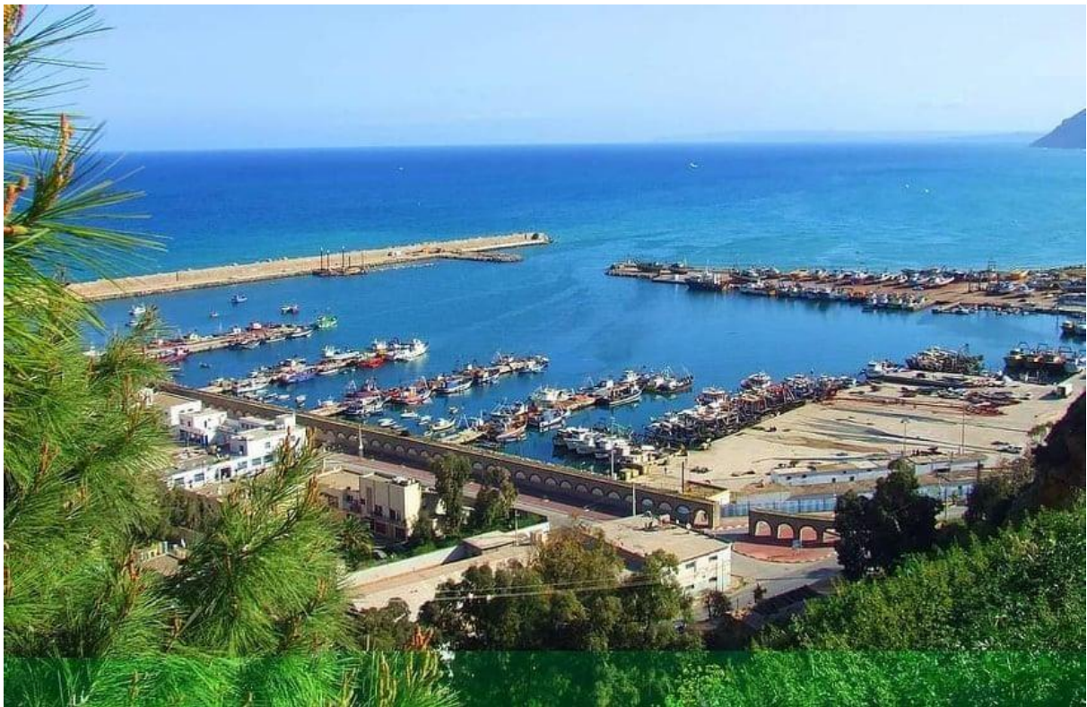
Figure n° 13 : Vue du port de Béni-Saf (Ramdani, 2022).
