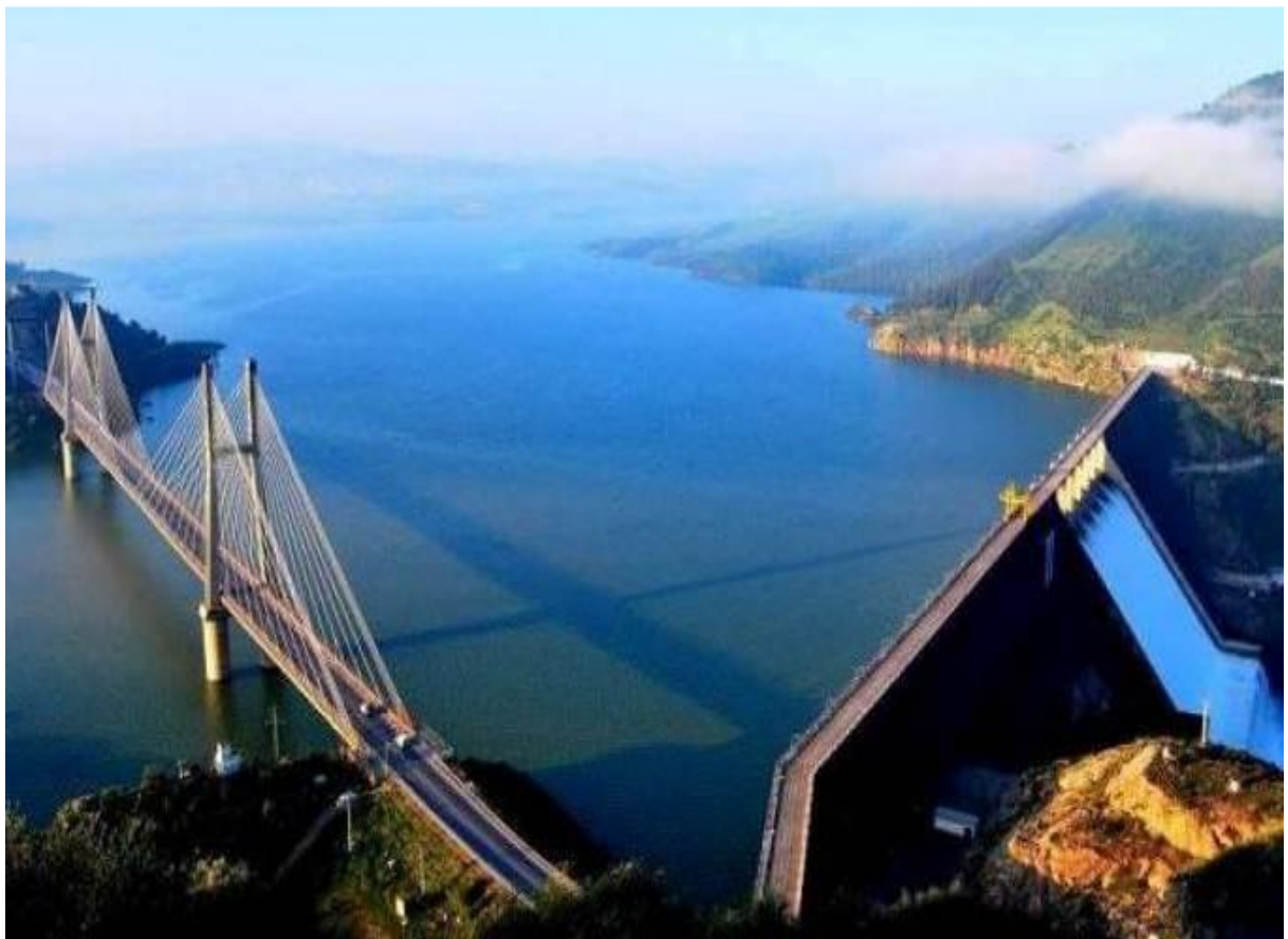
Figure 11 : Barrage de béni Haroun source (Chebli et Djamai,2016)
