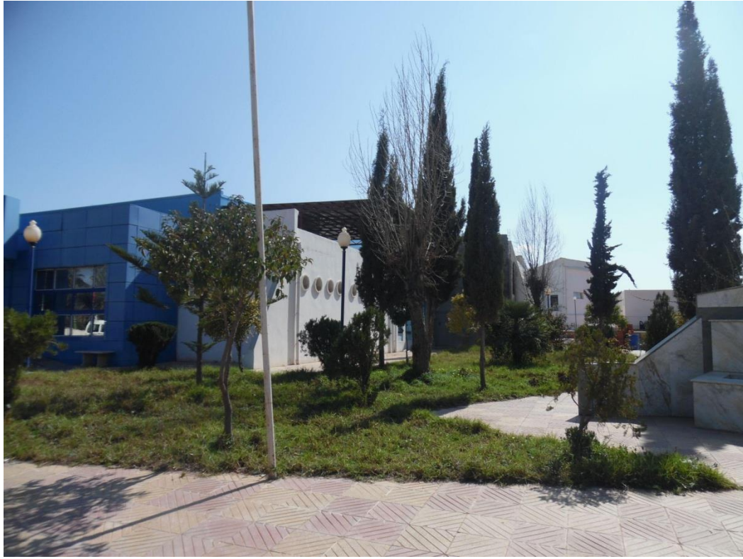
Photo 17: Espace vert de la piscine semi olympique de Maghnia.
