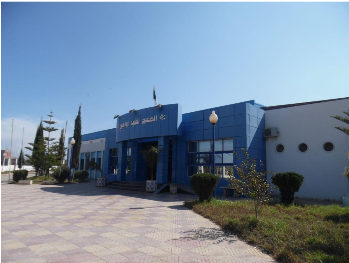
Photo 16: Vue générale de la piscine semi olympique de Maghnia
