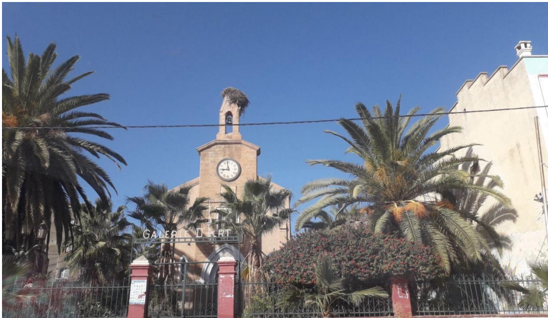
Photo 23: Vue générale sur la galerie d'art ( ancienne église) de Maghnia.
