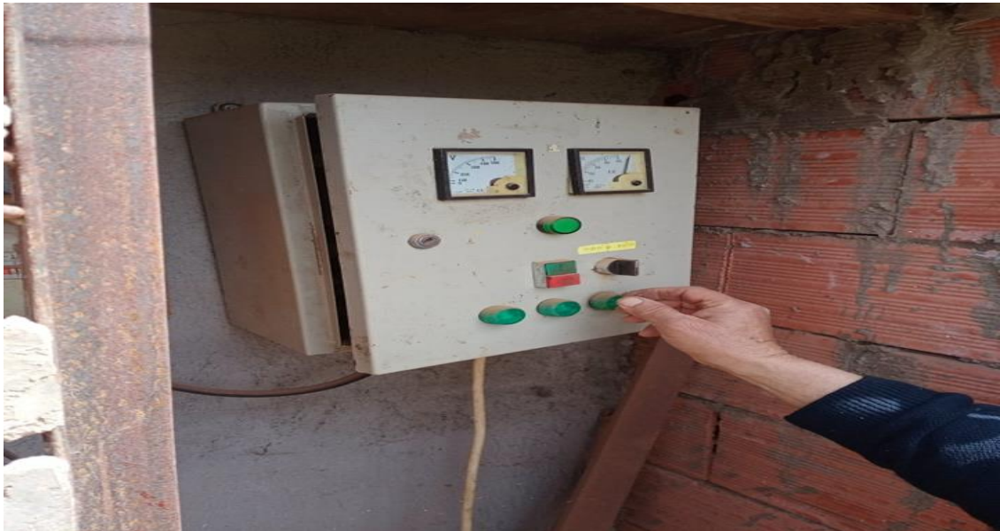
Figure 16: Tableau de commande électrique avec système de minuterie. (Ben yelles L., Sabra).
