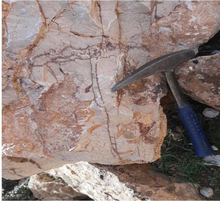
Figure 10 : Photo montrant des calcaires cristallins affectés par des Fissures perpendiculaires à la stratification
