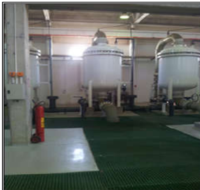
Figure 16 : Filtres à cartouches
