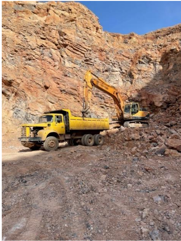
Fig. 25: Opération de chargement
