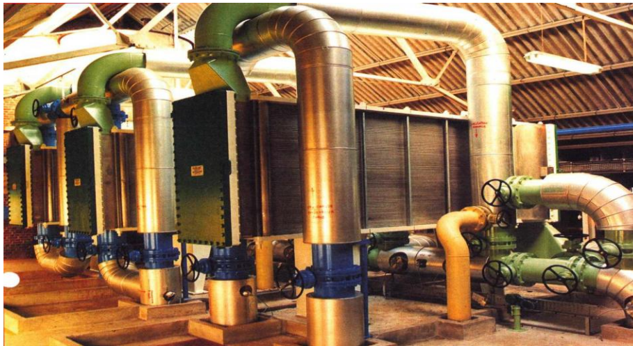
Figure II.5 : Echangeurs à plaques
