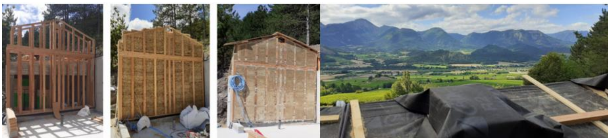
Figure 41 Photo du projet en cours de réalisation / Source http://archestra.fr/
