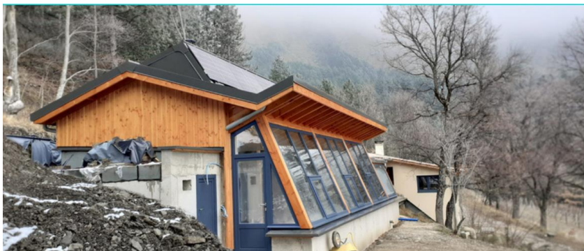
Figure 42 Photo du projet en cours de réalisation / Source http://archestra.fr/
