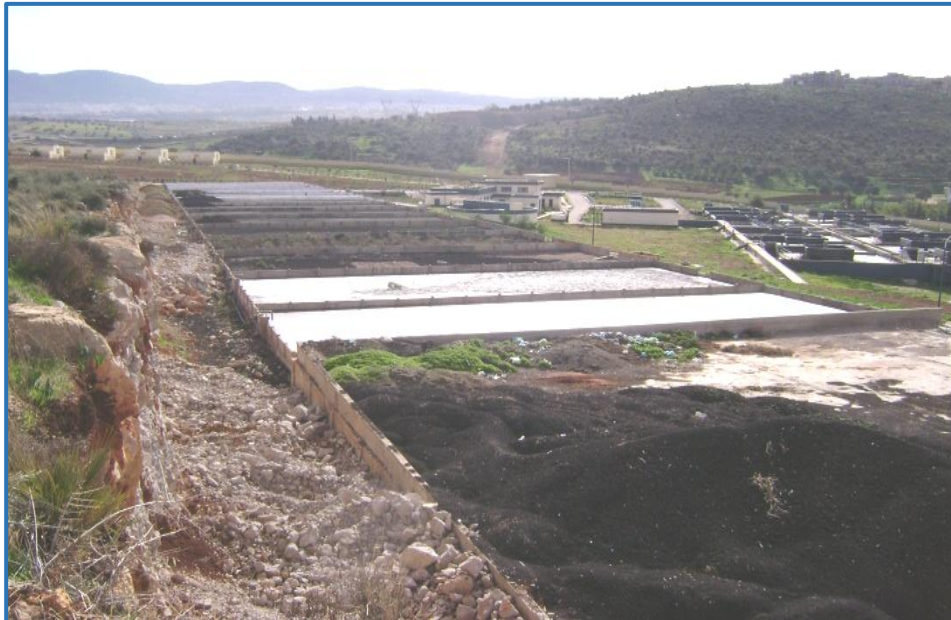
Photo N°10 : Lits de séchage & Aire de stockage(ONA)
