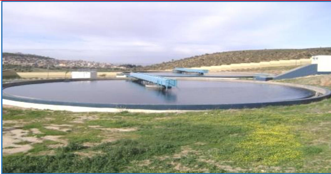
Photo N°06 : Décanteurs secondaires(ONA)
