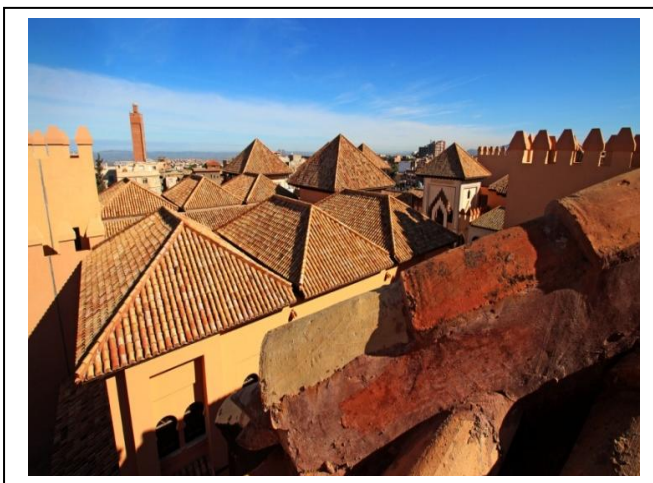
Fig 59 : Toiture du C.E.A. 67
