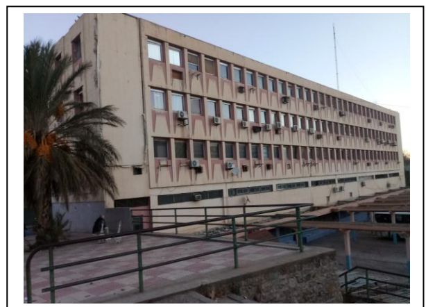
Fig 36 : Photo de façade principale du côté Rhiba 42
