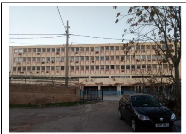
Fig 35 : Photo de façade principale à partir des logements
