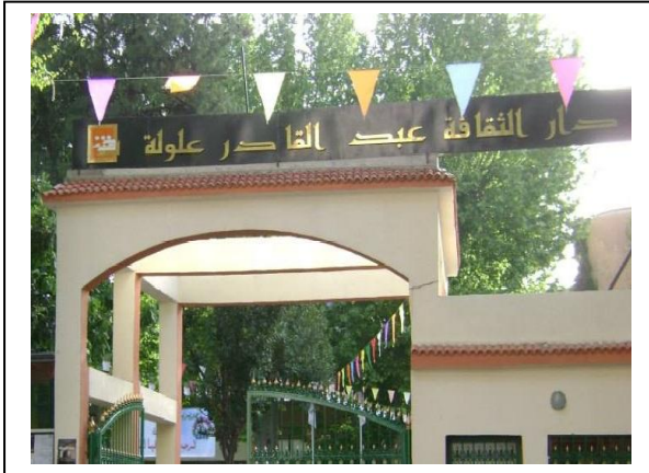
Fig 22: La maison de la culture de la Wilaya de Tlemcen
