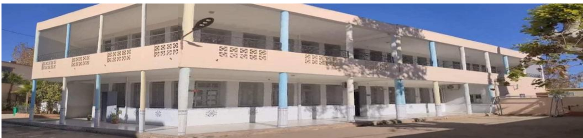
Figure II.32 : vue de façade intérieur bloc éducatif (traité par l'auteur)
