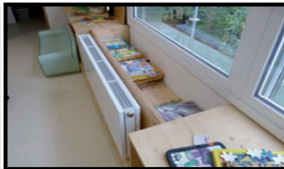
Figure III.25 : Vue des tablettes derrière 82
