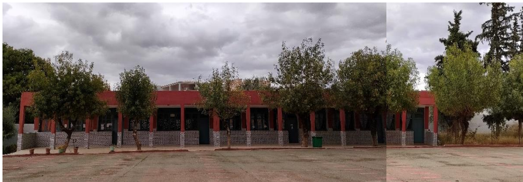
Figure II.28 : vue de façade intérieur du bloc éducatif + administratif (traité par l'auteur)
