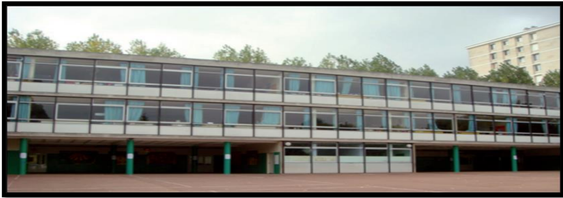
Figure III.21 : façade principale avant la réhabilitation 78
