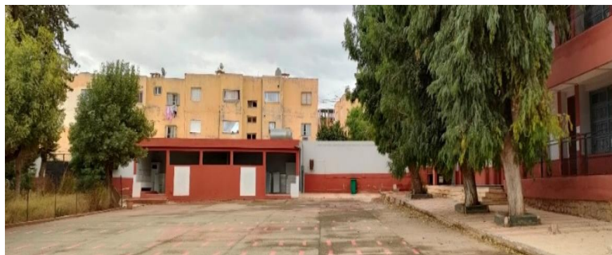
Figure II.29 : vue façade intérieur du bloc sanitaire (traité par l'auteur)
