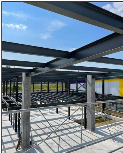
*Figure 74: Type de structure mixte béton / acier*<sup>138</sup>
