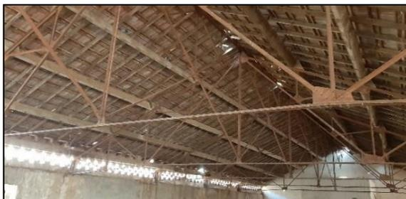
*Figure 30: Charpente métallique de la cave*<sup>84</sup>
