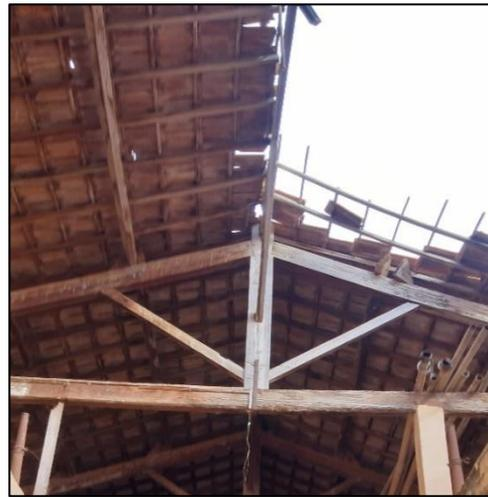
*Figure 72: État de la toiture d'une des caves <sup>136</sup>*
