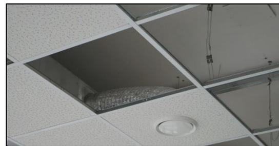
Figure 81: Modèle d'un faux plafond <sup>146</sup>
