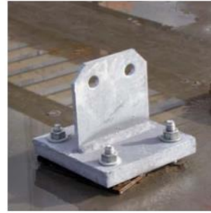
Figure 76 : Pied de poteau en acier galvanisé Source : Construction à ossature bois Le restaurant administratif du CETE de Lyon bv. transports.gouv.qc
