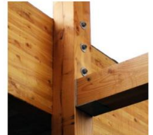
Figure 77 : Assemblage des poutres primaires sur les poteaux Source : Construction à ossature bois Le restaurant administratif du CETE de Lyon bv. transports. gov.qc
