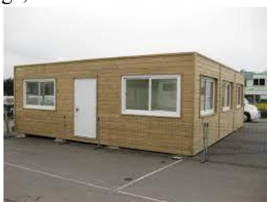
Figure 64 : les bâtiments assemblables Source : google photo
