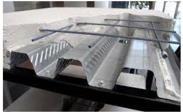
Figure 48 : Le Plancher collaborant préfabriqué Source : L'industrialisation de la Construction Cas d'étude : Un centre socio culturel (formation rencontre et développement social) à AIN TEMOUCHENT par bendimerad jacer
