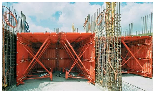
Figure 67 : Le coffrage tunnel Source : archiproducts.com
