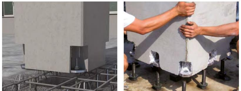
Figure 163 : la connexion par boulonnage Source : https://www.halfen.com/application/filebrowser/library/fr/media/catalogues/AW-Construction_Elements_Prefabrique_HALFEN.pdf
