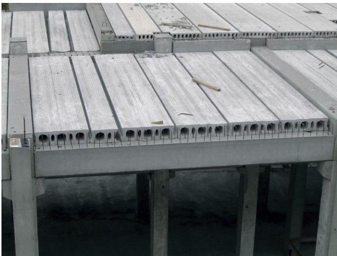
Figure 165 : la dalle alvéolaire préfabriquée source : google image
