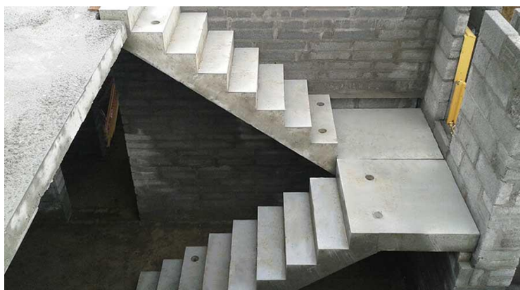
Figure 168 : escalier préfabriqué en béton armé Source : https://www.pavebeton.fr/escalier-en-beton/
