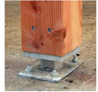
Figure 76 : Pied de poteau en acier galvanisé Source : Construction à ossature bois Le restaurant administratif du CETE de Lyon bv. transports.gouv.qc
