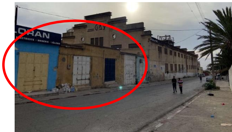
FIGURE 119 PHOTO LOCAUX RECENT A DEMOLIR SOURCE AUTEUR 20
