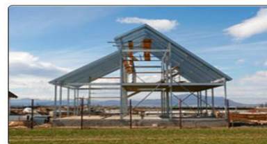
Figure 05 : Maison en acier Source :Coignet et Coignrt ,(2006)
