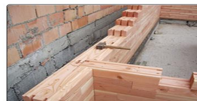
Figure 10: Maison en parpaing de bois Source : Coignet et Coignet,(2006)
