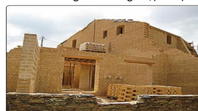
Figure 9: Maison en terre compressée Source : Benouali.(2015)
