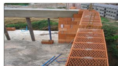
Figure 07: Maison en brique monomur Source : Tour(2010)
