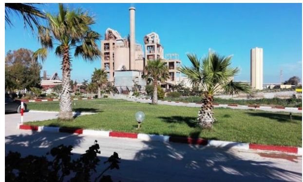
Figure 40 : Cimenterie de béni saf
