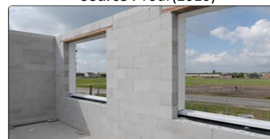
Figure 08: Maison en silico-calcaire Source :Coignet et Coignet,(2006)
