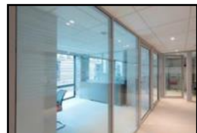
Figure 74 : cloison amovibles vitrée
