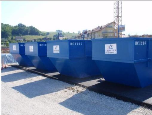
Figure 61 : Bennes pour la gestion de déchets de chantier
